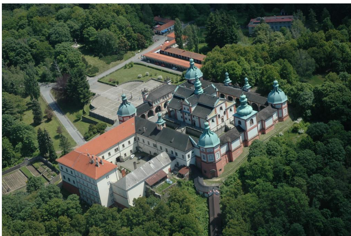
Obr. č. 2 Letecký pohled na Svatou Horu
