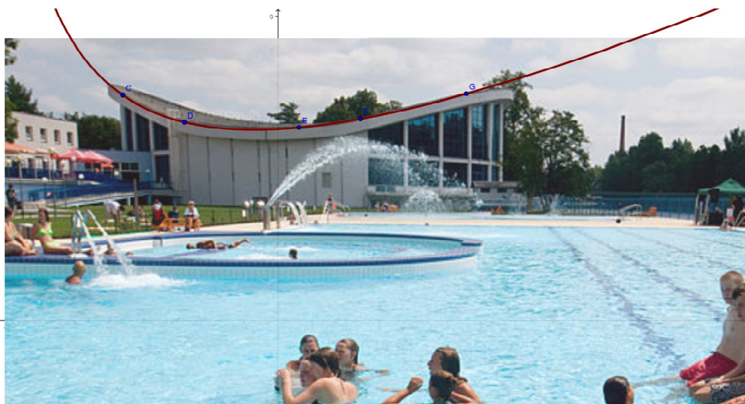
Foto 25 střecha bazénu v Českých Budějovicích [12]
