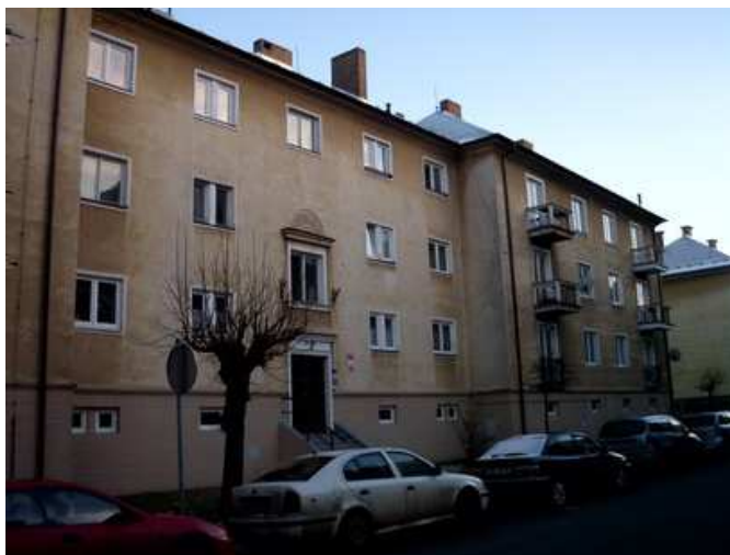
Foto 7. Plocha č. 7 Havlíčkova kolonie - bytovky u teplárny
