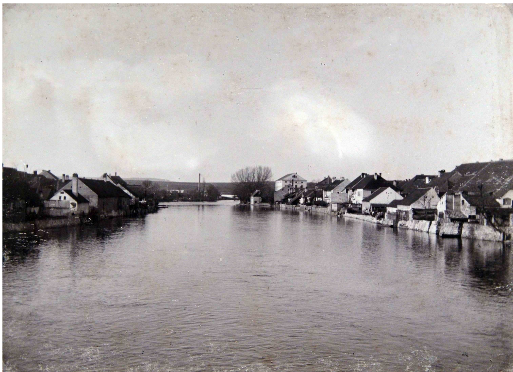
Příloha č. 4 – Pohled z Kamenného mostu po proudu řeky Otavy z 90. let 19. století, vlevo Čechova ulice (tehdejší název Portyč ), vpravo nábřeží 1. máje (tehdejší název Rybářská ulice ), foto V. Wietz (ze sbírek Prácheňského muzea v Písku)
