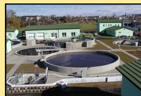
Obr. 29: Čistička odpadních vod v Telči
