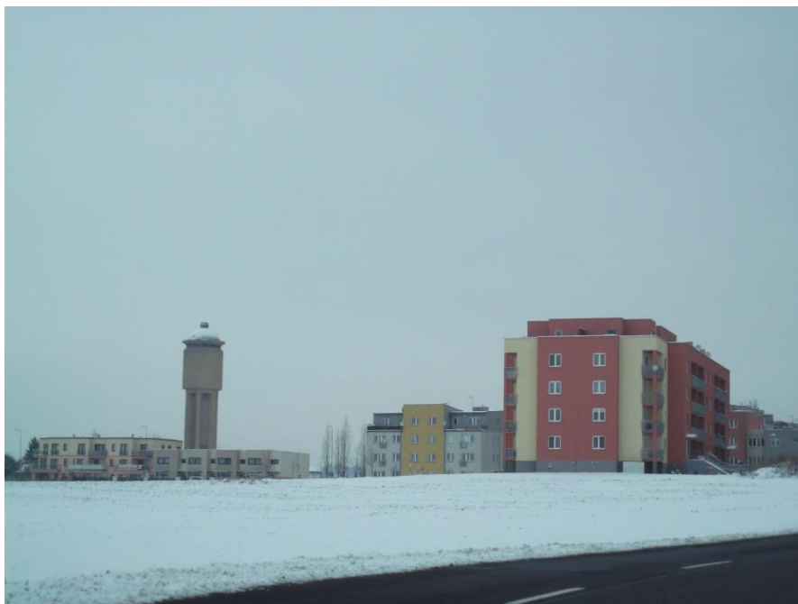
Obrázek 9 Sídliště U Vodárny v Kolíně vystavěné pro zaměstnance TPCA v roce 2006
