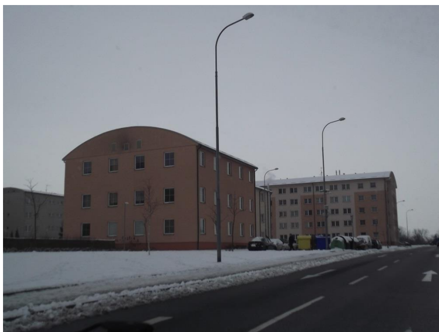
Obrázek 10 Sídliště Kasárna v Kolíně vystavěné pro zaměstnance TPCA v roce 2006
