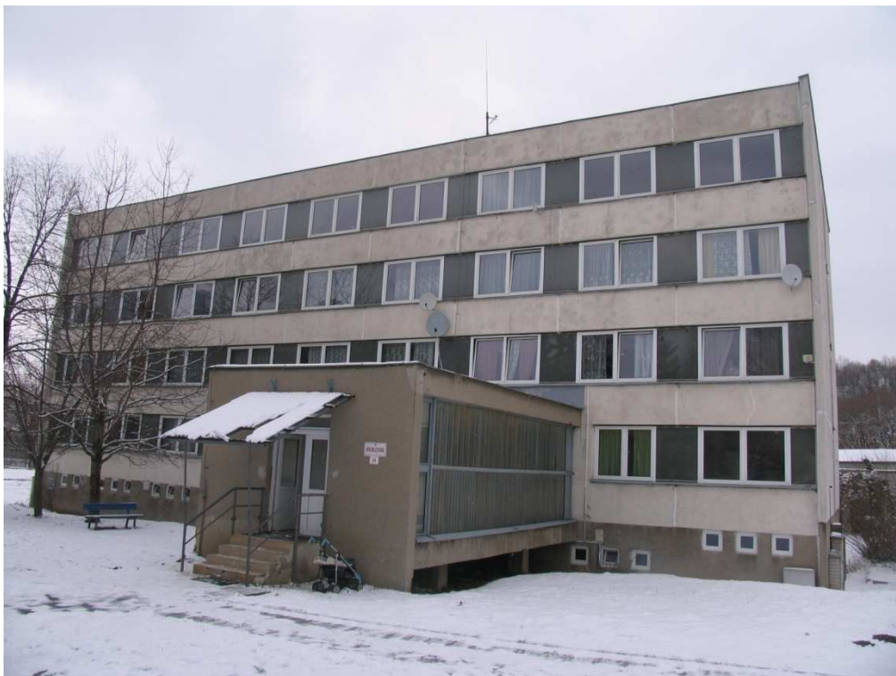
Obrázek 27 - Pohled na dům v Krumlovské ulici čp. 39 ve městě Prachatice.
