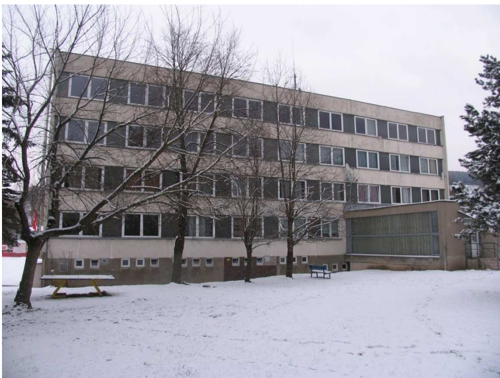
Obrázek 26 - Pohled na dům v Krumlovské ulici čp. 39 ve městě Prachatice.
