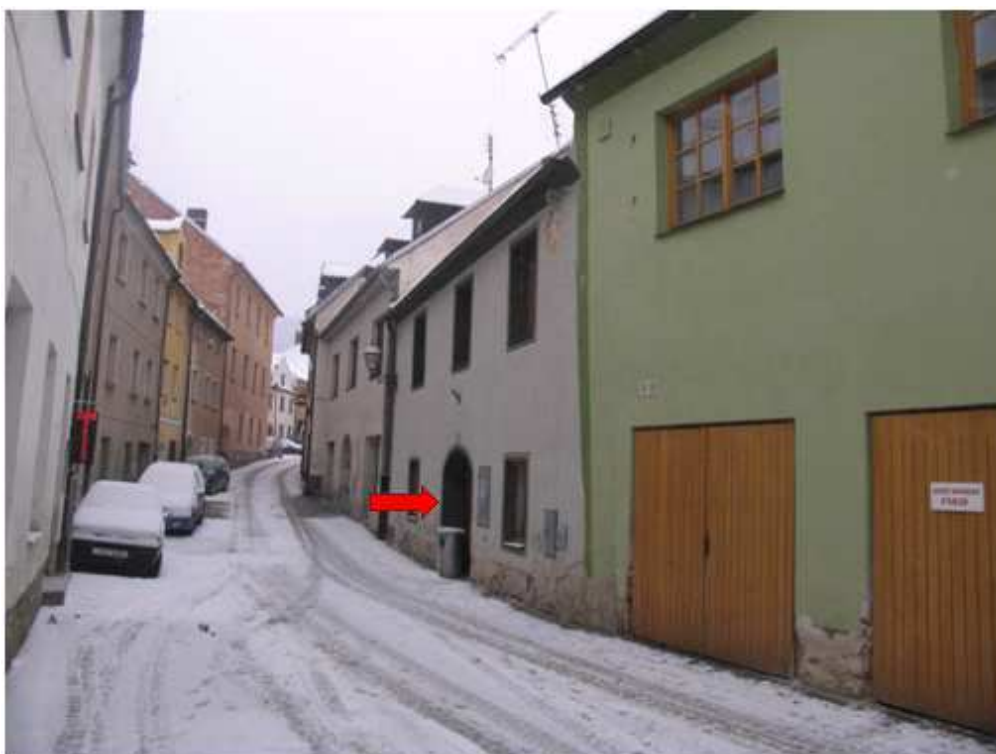
Obrázek 16 - Pohled na dům v Dlouhé ulici čp. 116 ve městě Prachatice.
