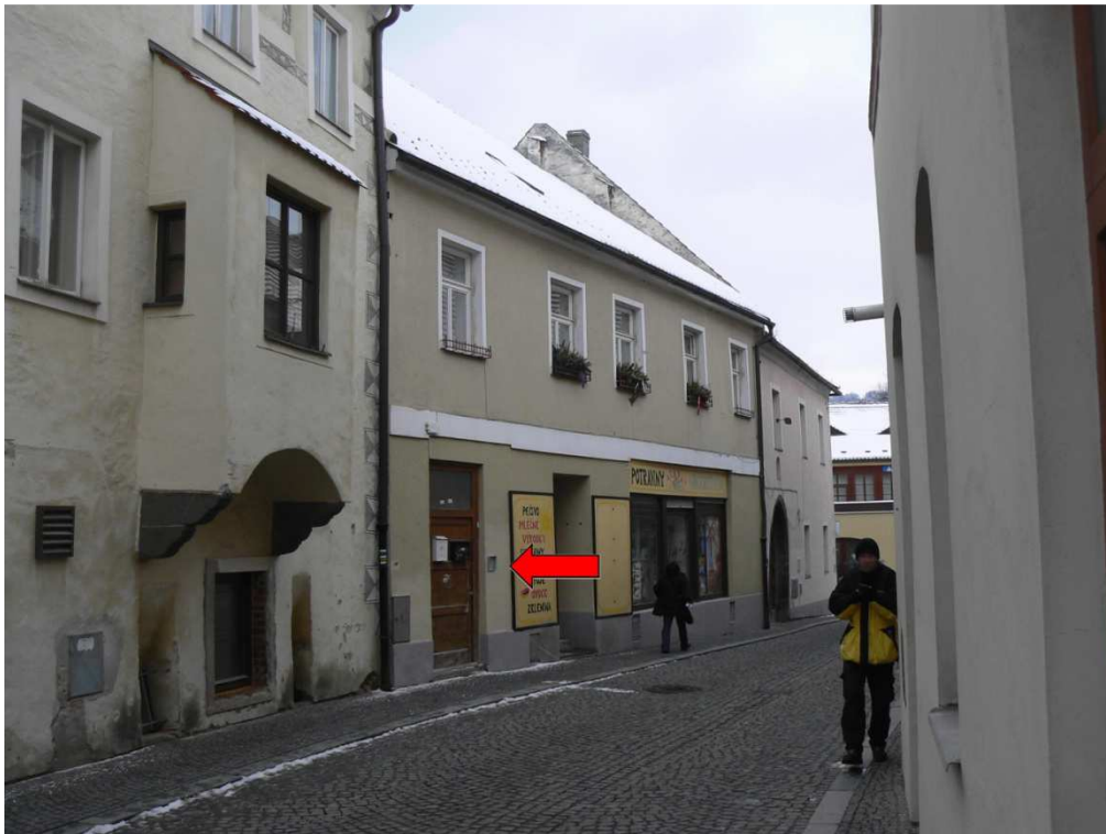
Obrázek 19 - Pohled na dům v Solní ulici čp. 120 ve městě Prachatice.
