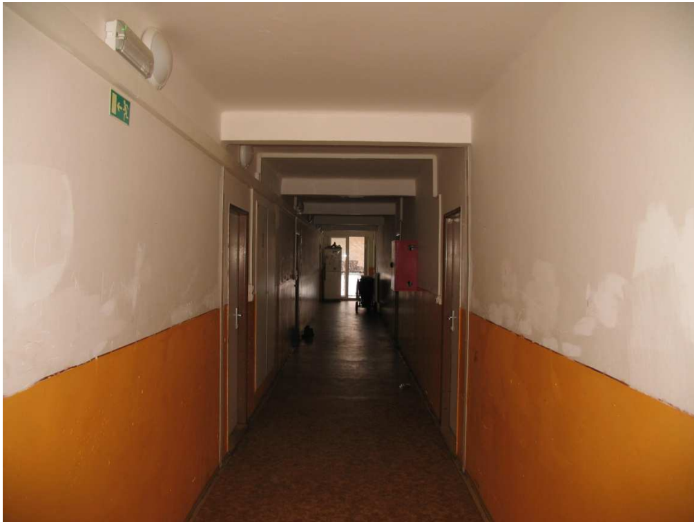
Obrázek 34 - Pohled na chodbu domu v Krumlovské ulici čp. 39 v Prachaticích.
