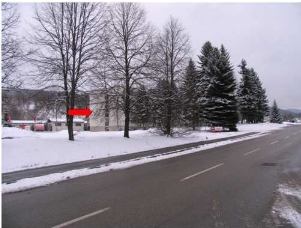
Obrázek 21 - Pohled na dům v Krumlovské ulici čp. 39 ve městě Prachatice.
