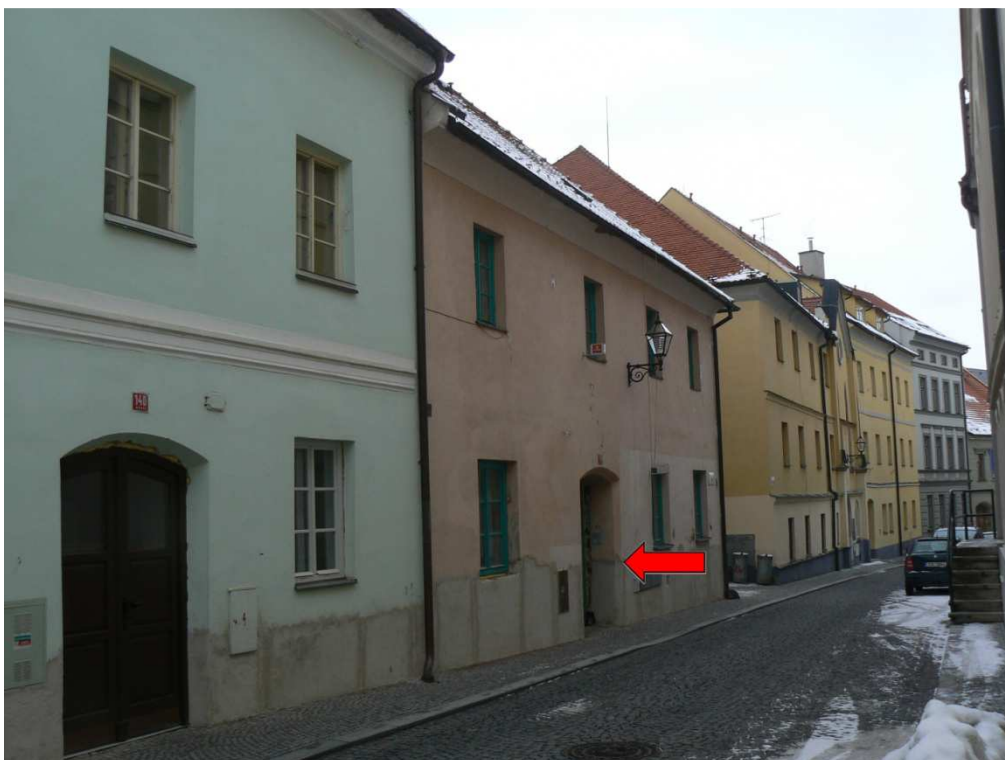
Obrázek 3 - Pohled na dům v Horní ulici čp. 141 ve městě Prachatice.
