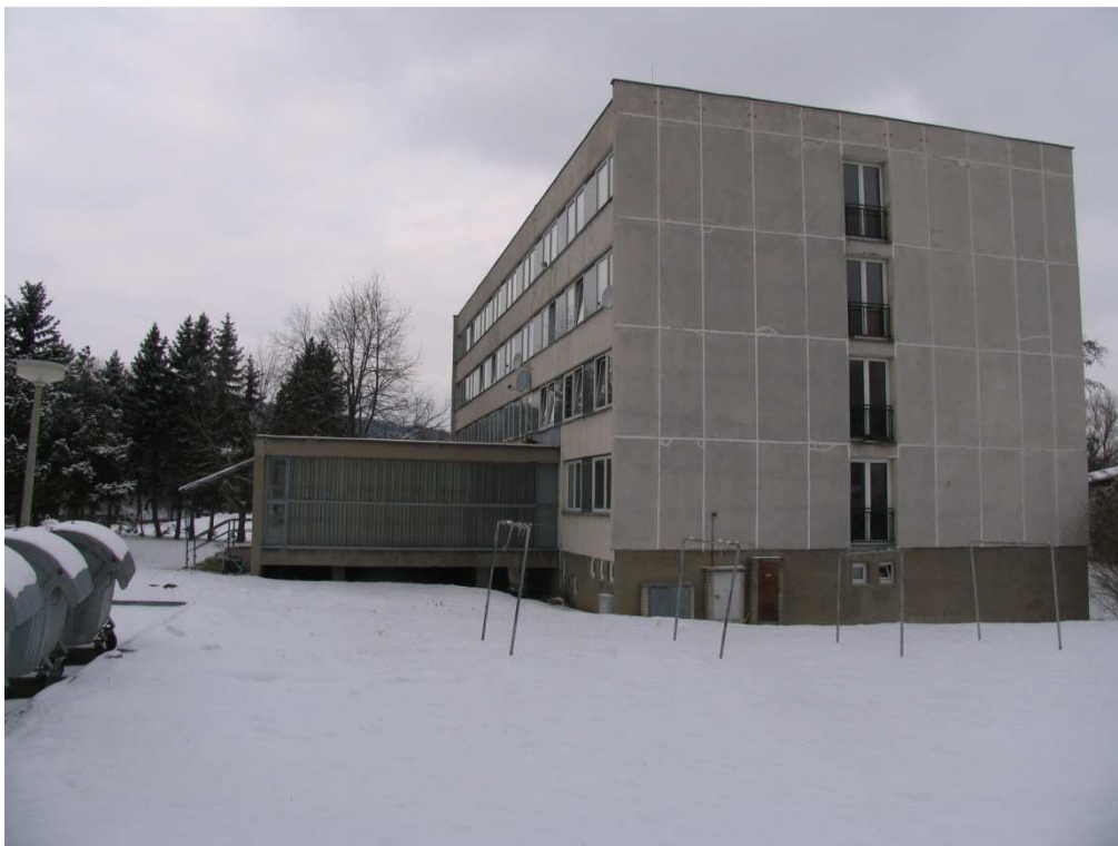
Obrázek 29 - Pohled na dům v Krumlovské ulici čp. 39 ve městě Prachatice.
