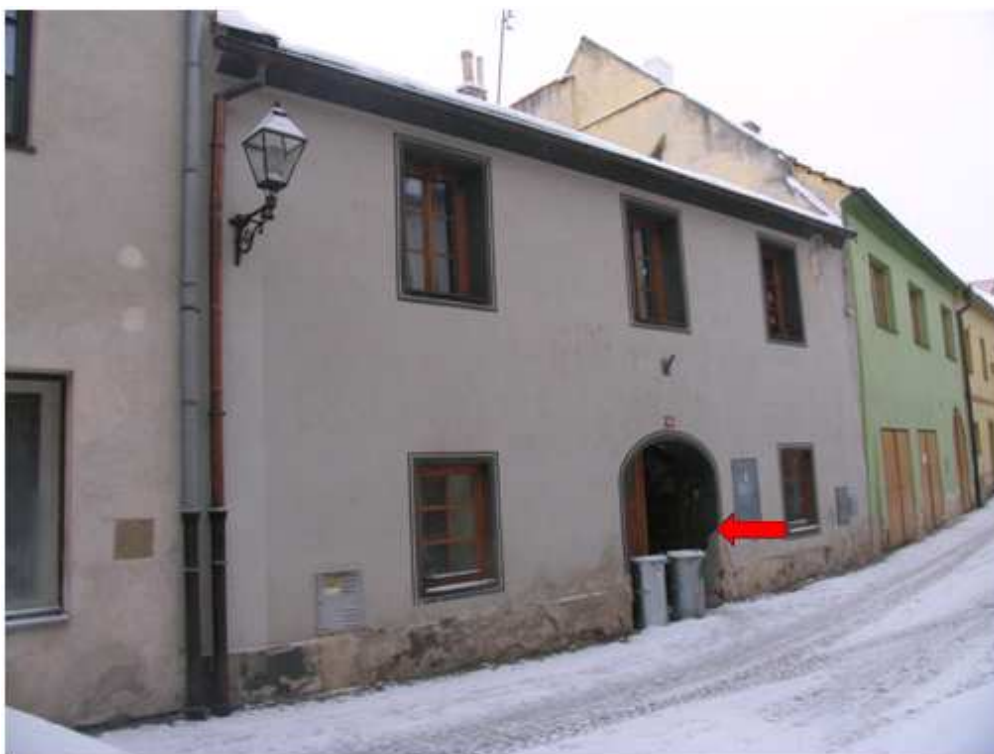
Obrázek 14 - Pohled na dům v Dlouhé ulici čp. 116 ve městě Prachatice.
