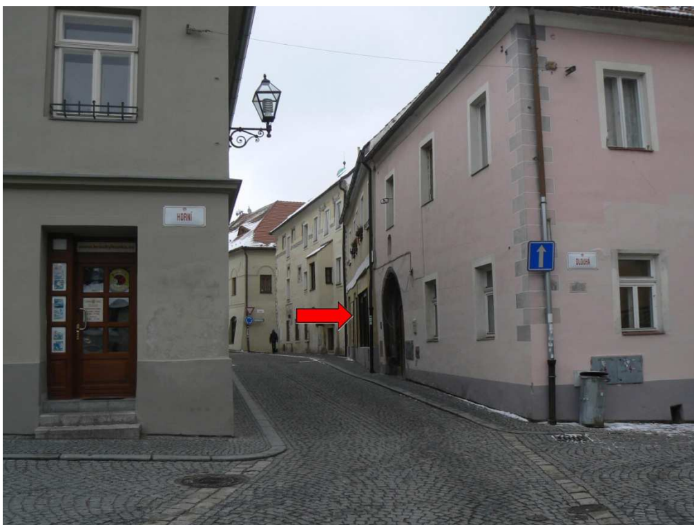
Obrázek 18 - Pohled na dům v Solní ulici čp. 120 ve městě Prachatice.
