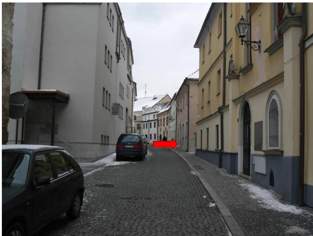
Obrázek 1 - Pohled na dům v Horní ulici čp. 141 ve městě Prachatice.
