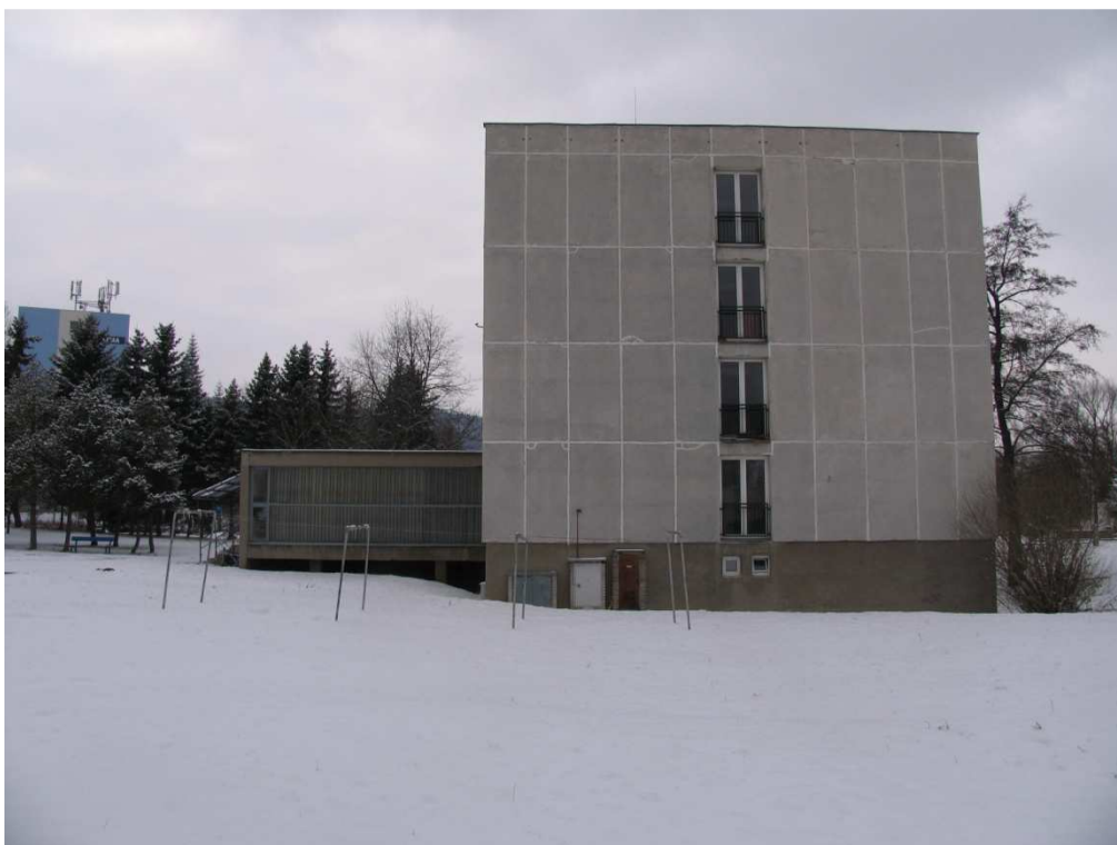
Obrázek 30 - Pohled na dům v Krumlovské ulici čp. 39 ve městě Prachatice.
