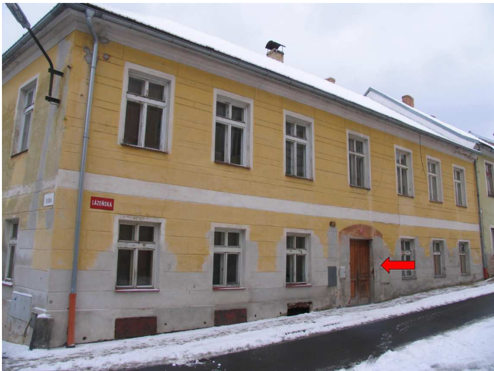
Obrázek 8 - Pohled na dům v Lázeňské ulici čp. 190 ve městě Prachatice. Zdroj: vlastní
