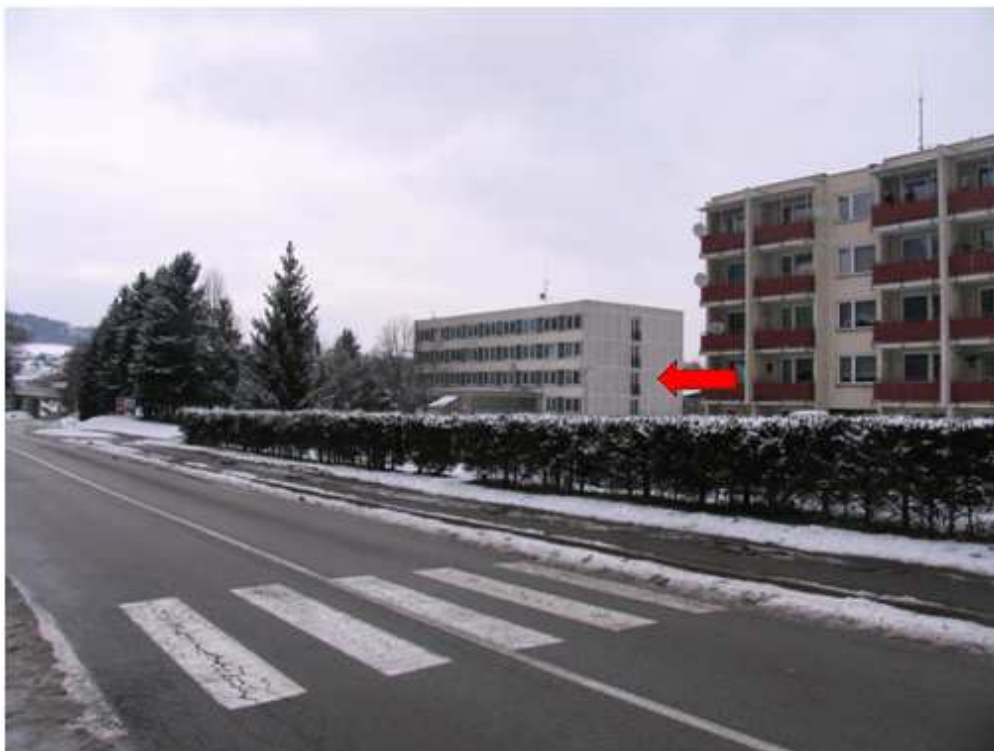
Obrázek 22 - Pohled na dům v Krumlovské ulici čp. 39 ve městě Prachatice.
