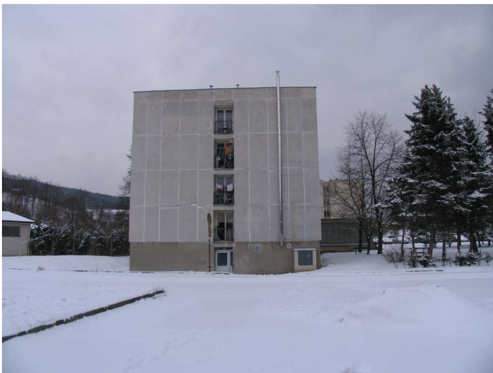
Obrázek 24 - Pohled na dům v Krumlovské ulici čp. 39 ve městě Prachatice.
