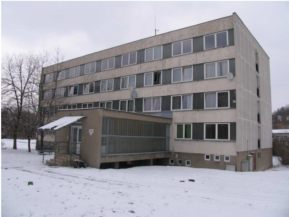
Obrázek 28 - Pohled na dům v Krumlovské ulici čp. 39 ve městě Prachatice.
