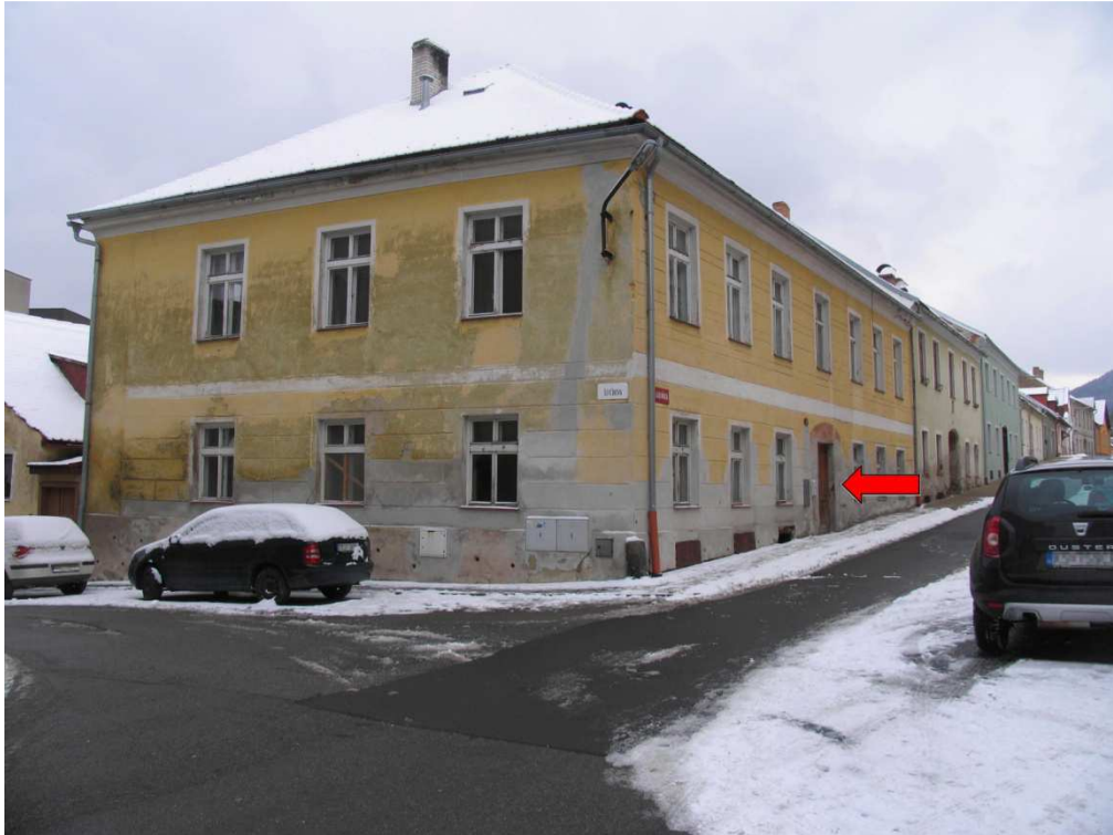
Obrázek 7 - Pohled na dům v Lázeňské ulici čp. 190 ve městě Prachatice. Zdroj: vlastní
