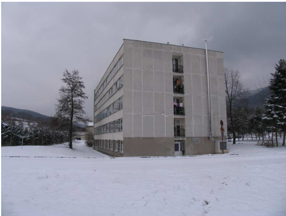
Obrázek 23 - Pohled na dům v Krumlovské ulici čp. 39 ve městě Prachatice.
