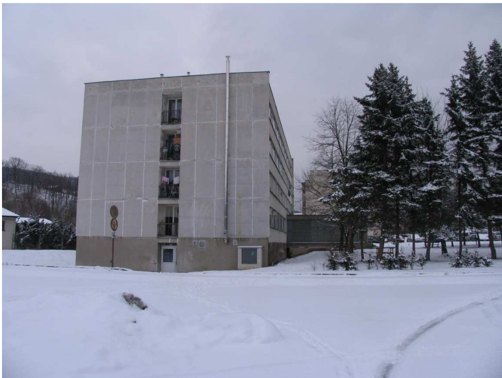
Obrázek 25 - Pohled na dům v Krumlovské ulici čp. 39 ve městě Prachatice.
