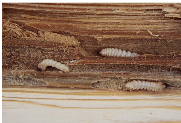
Obr. 43 – Larvy tesaříka krovového, převzato a upraveno z [18]
