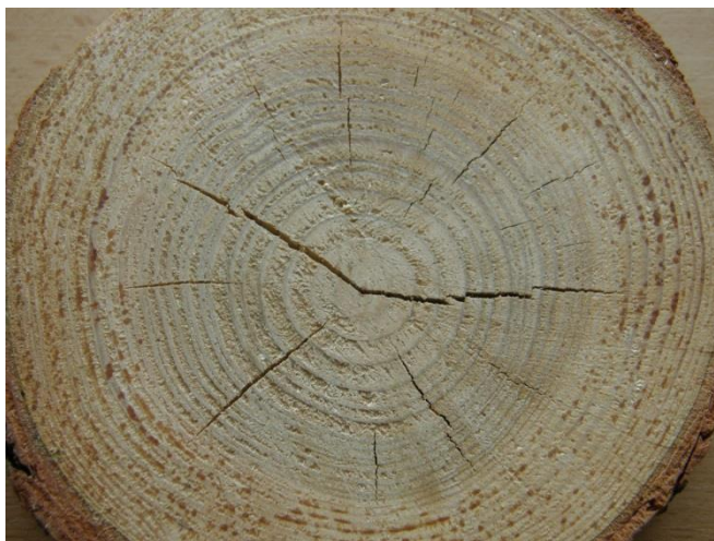
Obr. 16 – Výsušné trhliny (dřeňová lomená)
