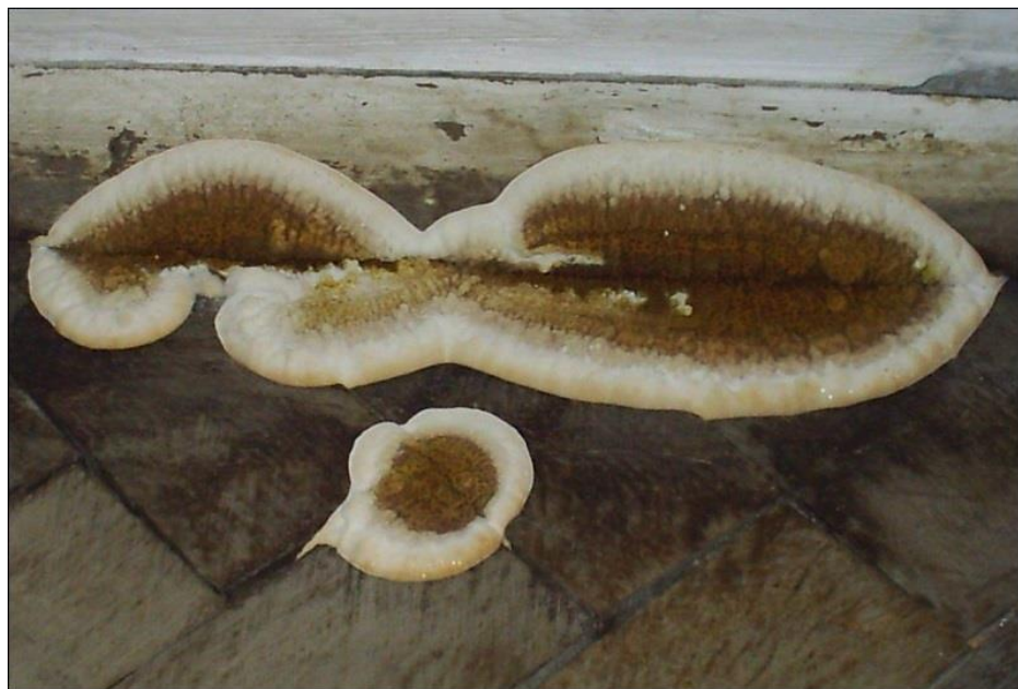
Obr. 82 – Dřevomorka domácí, převzato a upraveno z [34]
