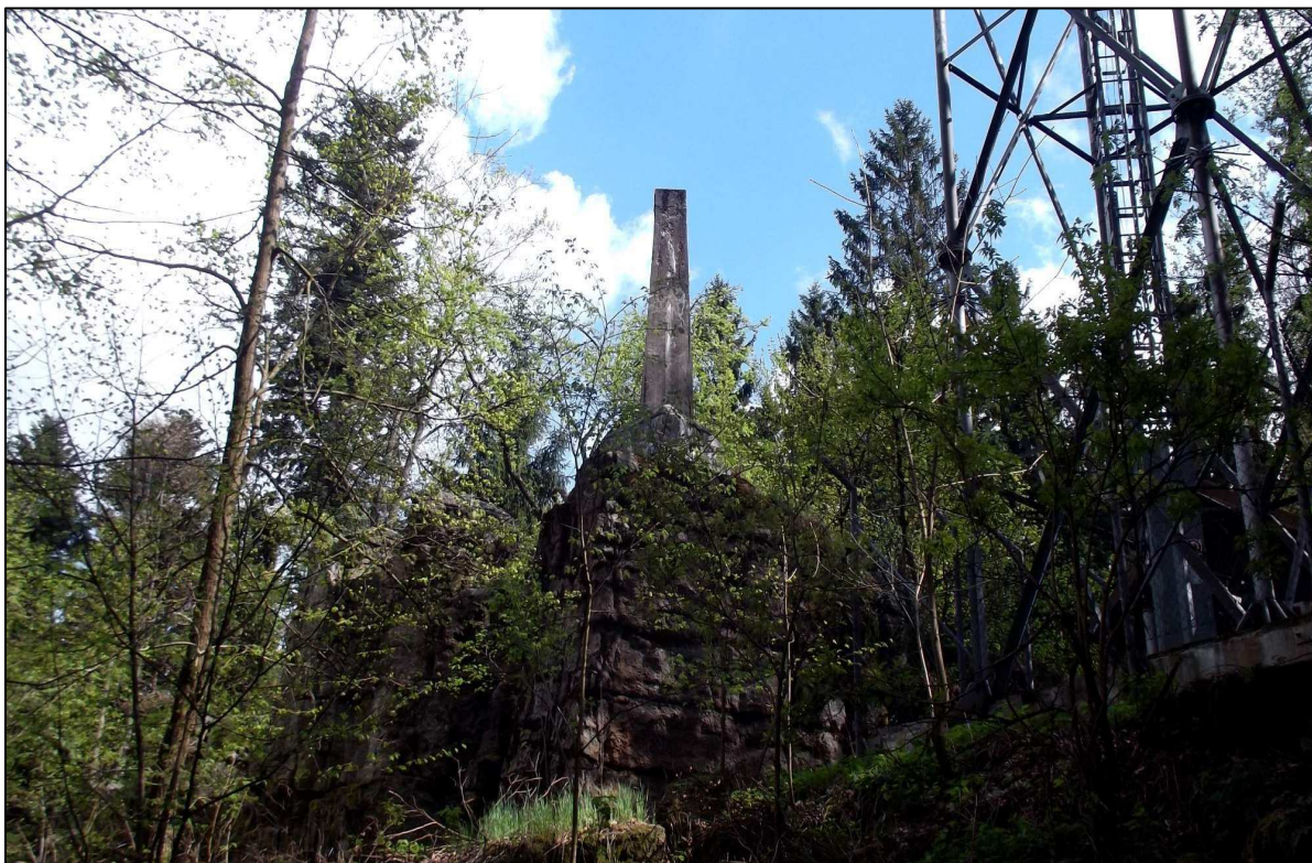
Foto 01: Pohled na část skalní hradby
