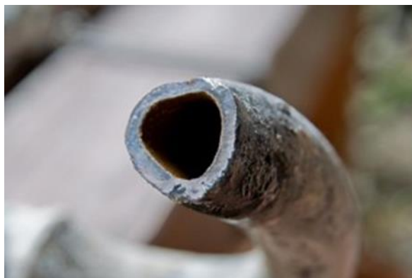
Obr. č. 10 Olověné potrubí [19]
