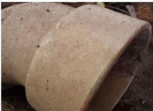
Obr. č. 21 Azbestocementové odpadní potrubí [34]
