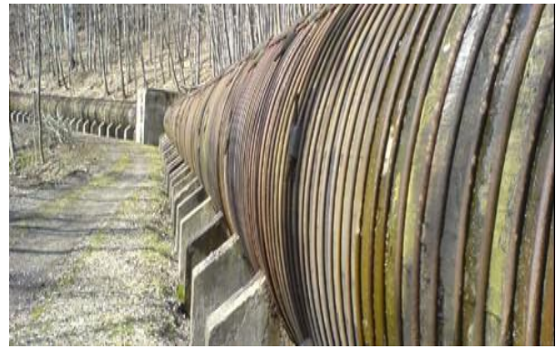
Obr. č. 2 Dužinové dřevěné potrubí [15]
