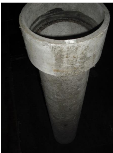
Obr. č. 13 Azbestocementové potrubí [17]
