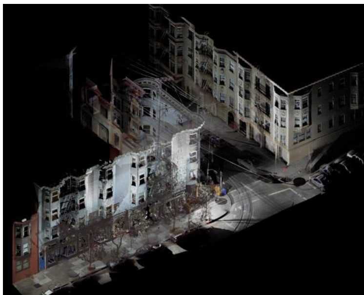
Obrázek 1 Laserové skenování budov [17]
