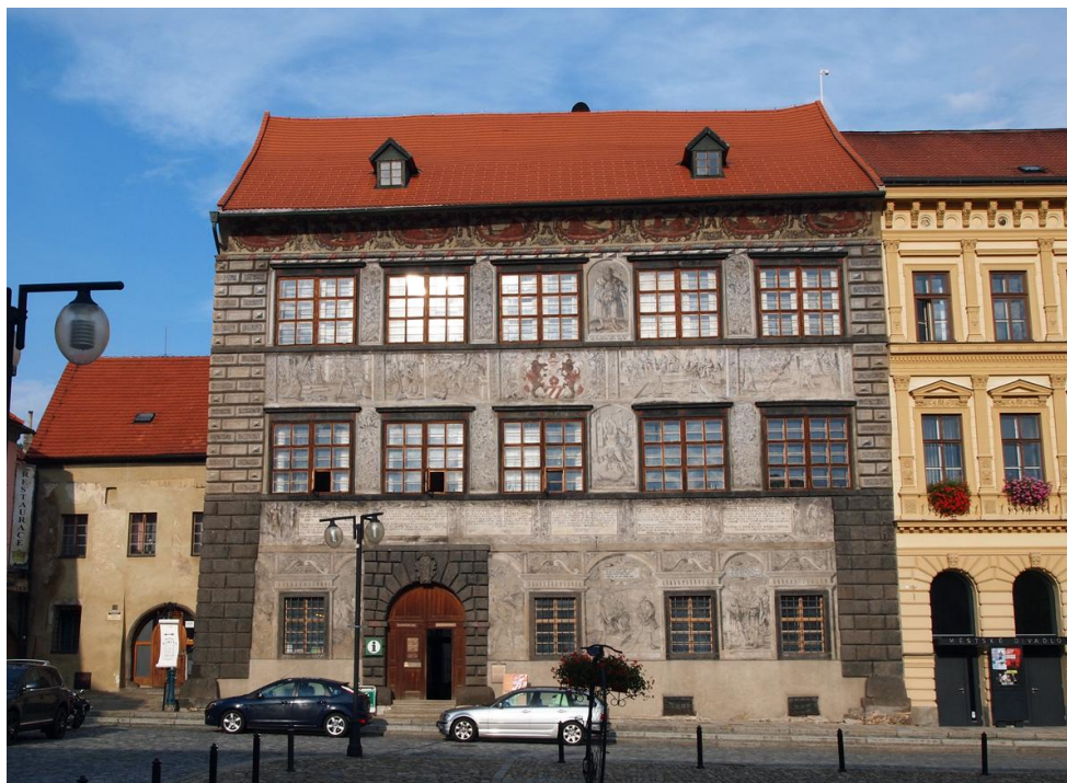
50. Budova radnice, souč. stav. Pohled na čelní fasádu.
