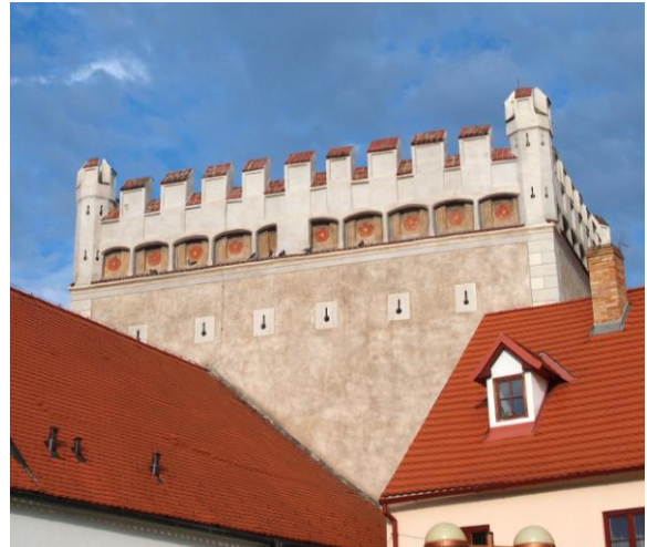
39. Pohled od jihovýchodu.
