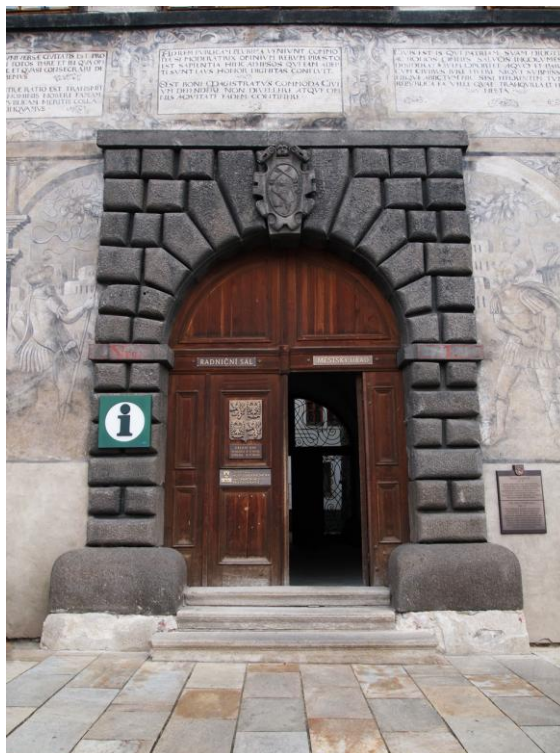
54. Hlavní vchod radniční budovy. Portál zdobí žulová bosáž a rollwerková kartuš se znakem města.
