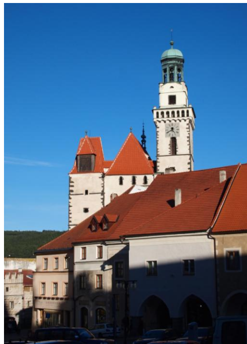
12. Záp. průčelí, od r. 1544 výhled na kostel zakrývá vestavěný blok obytných budov na Velkém náměstí.
