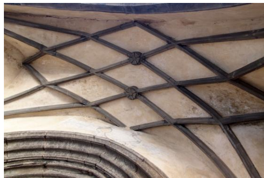
27. Síťová žebrová klenba při hlavním portálu, svorníky s dekorem pětistých růží.
