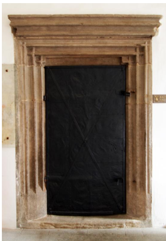
55. Kamenný portál k síni přízemí. Patrna gotická profilace přetínavého ostění, avšak celek s naddveňní římskou již směřuje k renesančnímu pojetí.
