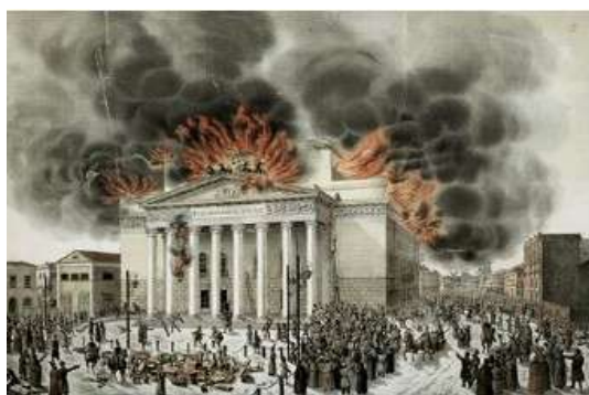
Obr. č. 6: Požár roku 1853 7
