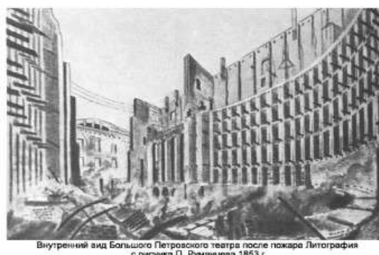
Obr. č. 7. : Budova divadla po požáru 8
