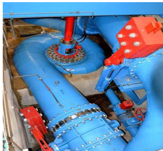
Obr. 5.2.2.9 Francisova turbína MVE, převzato a upraveno z [39]
