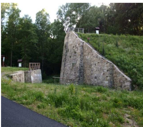
Obr. 3.1.23 Opěrné zdi vysokého dřevěného Mostu u Dolního Dvořiště
