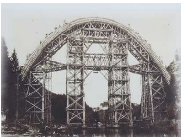
Obr. 5.1.4.1 bednění pro mostní oblouk
