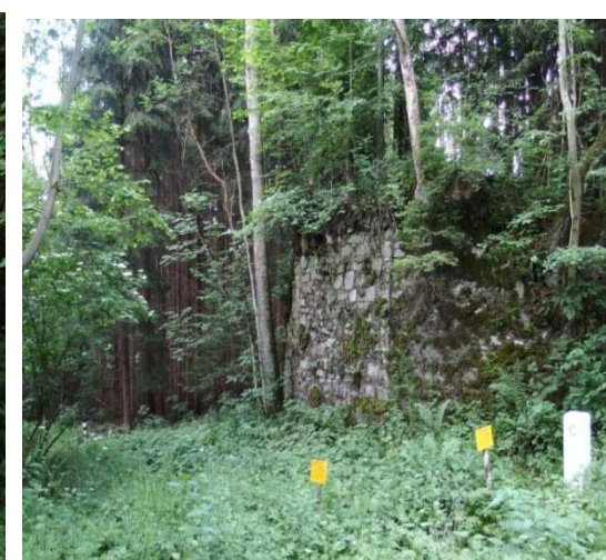
Obr. 3.1.28 Pravý pilíř dřevěného mostu Česko – Rakouské hranici s hraničním kamenem v popředí
