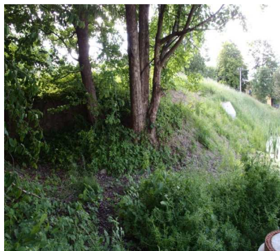
Obr. 3.1.20 Násep u opěrného pilíře mostu Rybník
