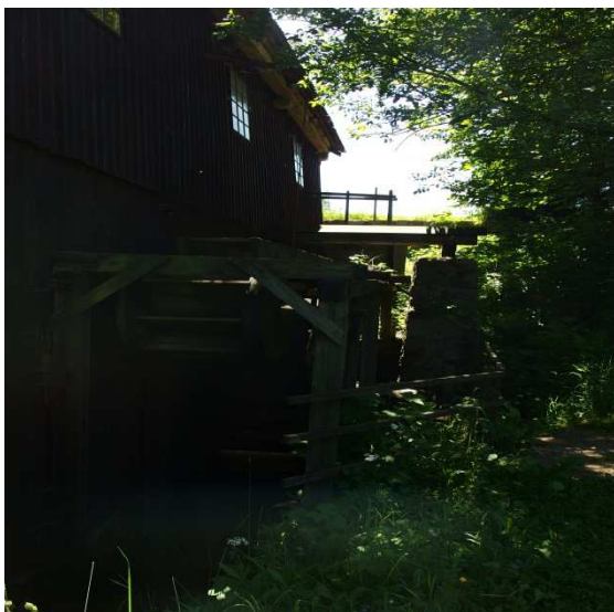
Obr. 4.1.8 Malé vodní kolo posuvu vozíku
