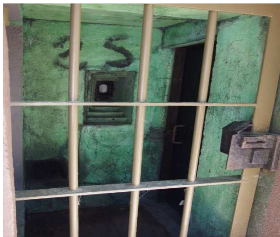
Obr. 6.2.4 Objekt A-140 vstup
