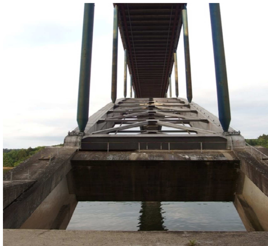
Obr.5.1.6.3 Příhradová konstrukce oblouků
