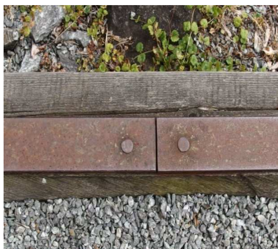
Obr. 3.1.14 Bujanov rekonstrukce kolejí - spoj
