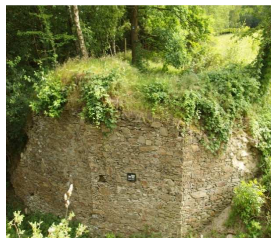
Obr. 3.1.16 Opěrný pilíř mostu a násep u Trojan
