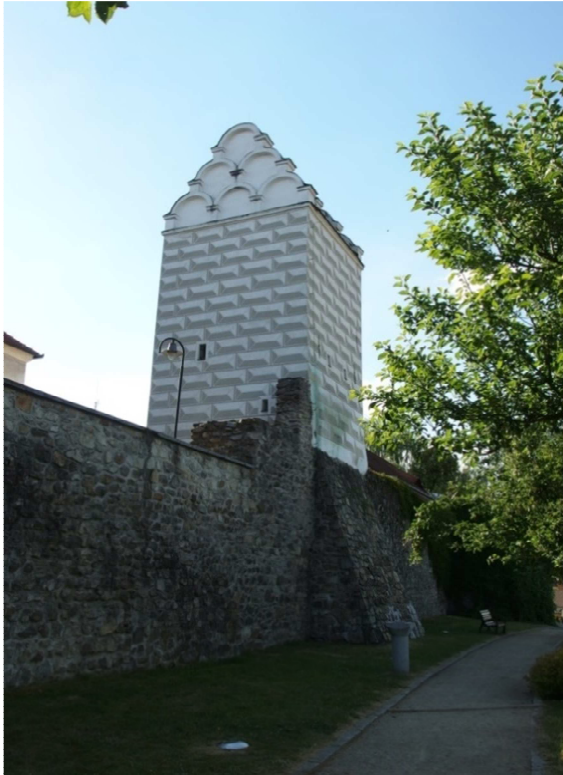
Obr. 6.1.18 Horní vodárenská věž
