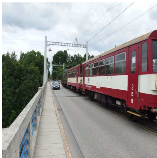
Obr.5.1.4.4 Souběžná železniční a automobilová přeprava na mostě
