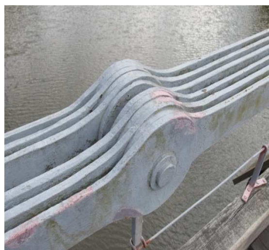
Obr.5.1.3.3 Detail uchycení nosníku
