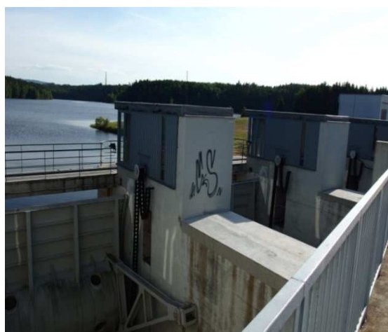
Obr. 5.2.2.5 Uzávěry přepadu hráze
