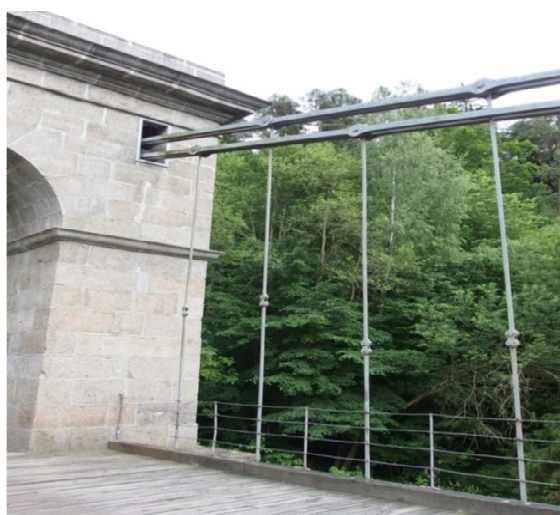
Obr.5.1.3.2 Uchycení nosníků mostovky
