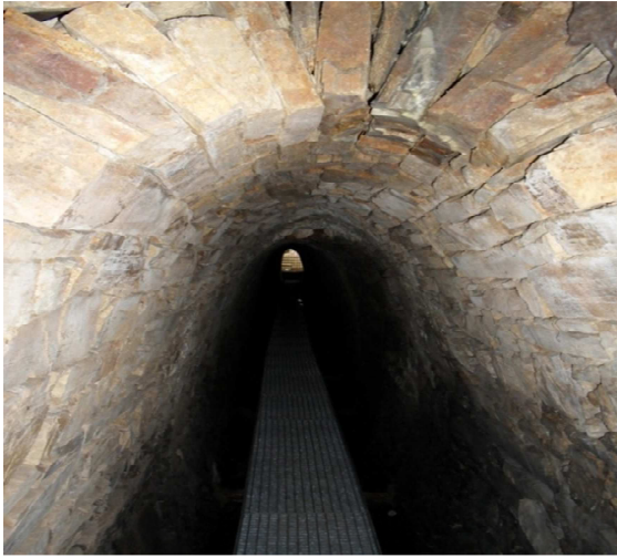
Obr. 2.1.3 Zpevněná část štoly z r. 2012
