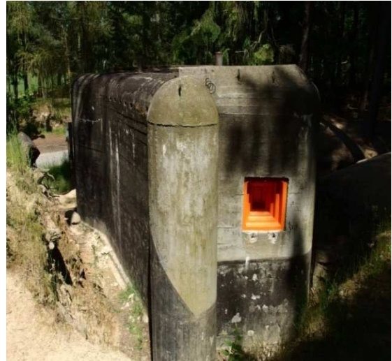
Obr. 6.2.15 Objekt A-140 (č.1052)
