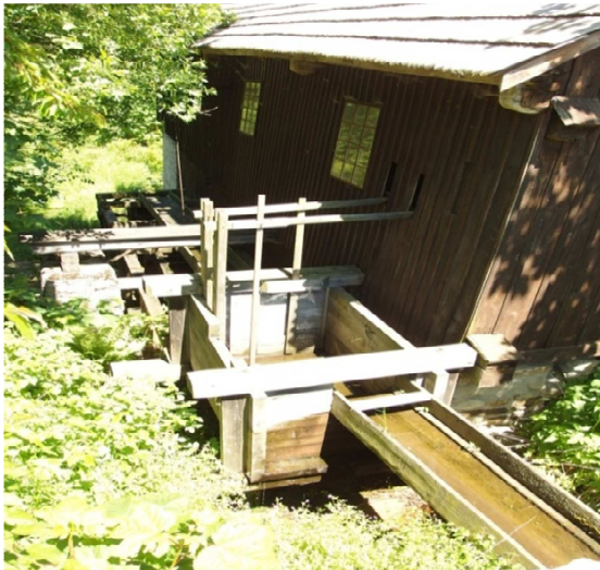
Obr. 4.1.2. Náhon s nátokovou skříní bez vody
