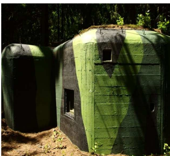
Obr. 6.2.12 Objekt A-160 v držení A.Č.R.
