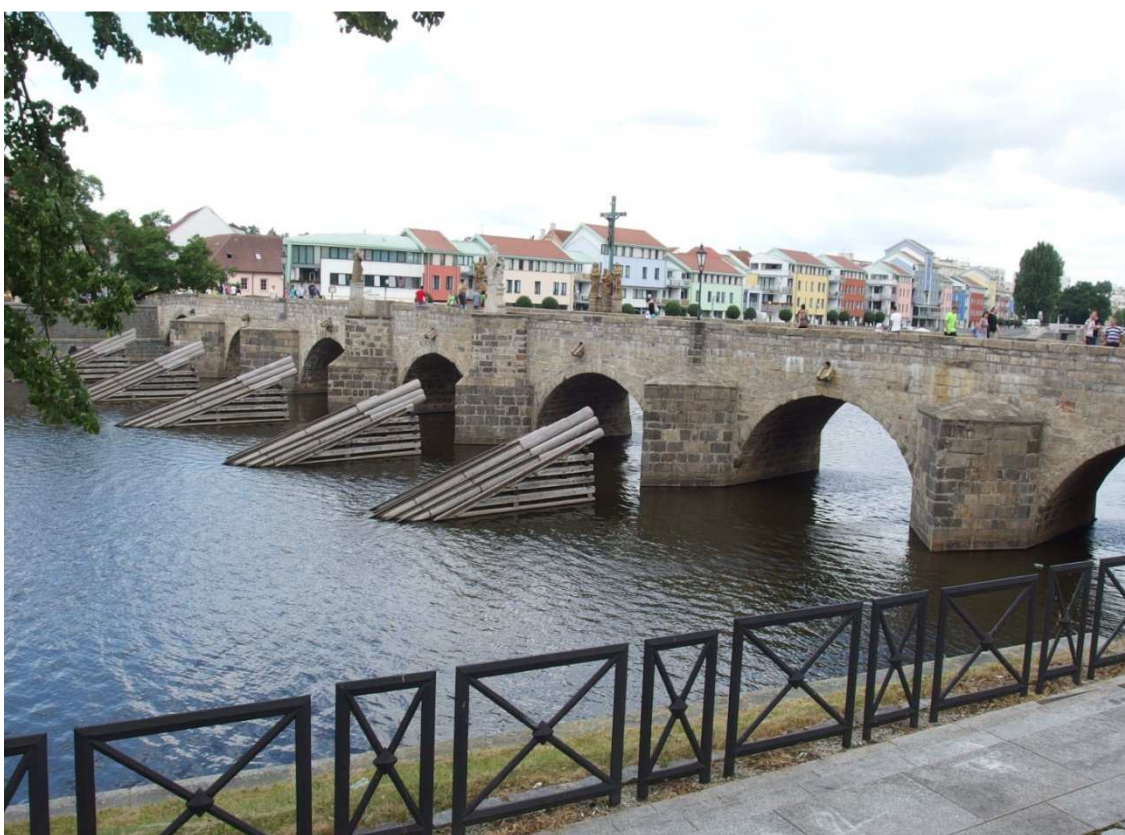
Obr.5.1.1.1 Kamenný most v Písku s návodnou stranou s ledolamy
