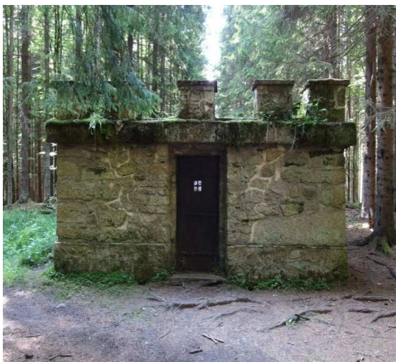
Obr. 3.3.3 Vstup ke kontrolní šachtě tunelu
