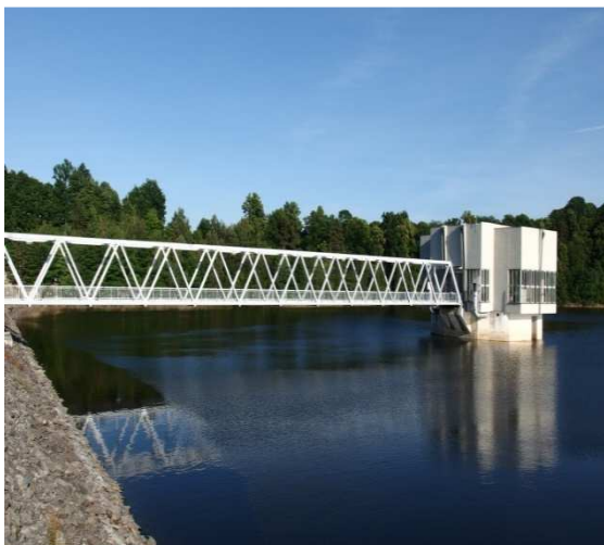
Obr. 5.2.2.2 Věž pro čerpání pitné vody
