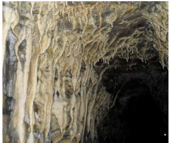
Obr. 2.1.6 Na některých částech stěn jsou krápníky
