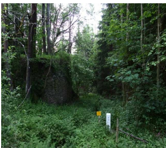
Obr. 3.1.27 Levý pilíř dřevěného mostu na Česko – Rakouské hranici s hraničním kamenem v popředí
