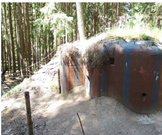
Obr. 6.2.2 Objekt A-140 (č.1315)
