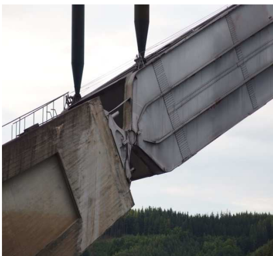
Obr.5.1.6.4 Detail kloubu oblouku
