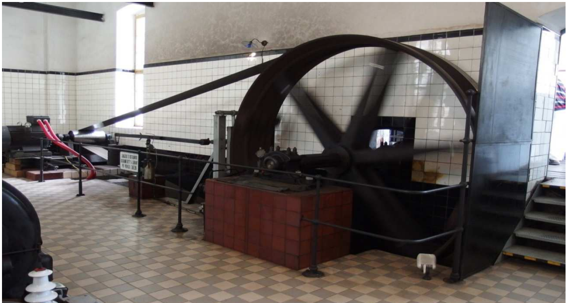
Obr. 4.4.5 Soustrojí elektrárny s velkým hnacím kolem a alternátorem na 3f ~ proud
