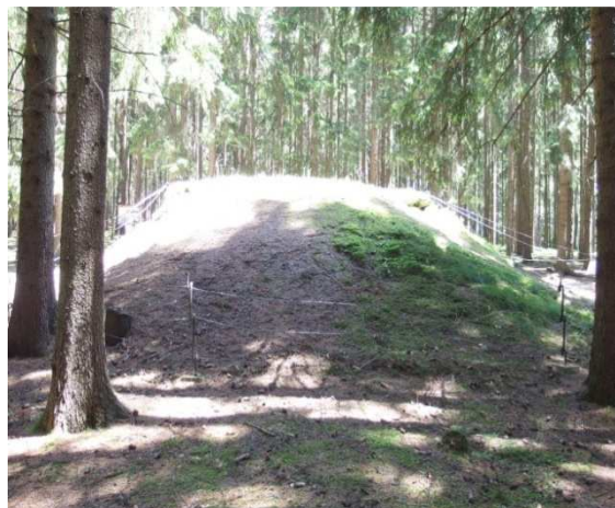
Obr. 6.2.3 Objekt A-140 (č.1315), čelní strana
