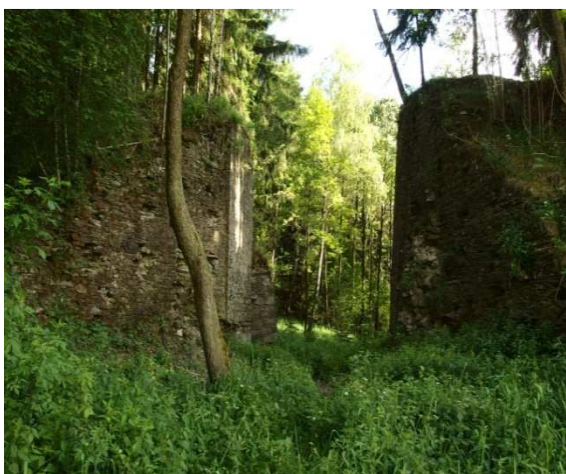
Obr. 3.1.17 Opěrné pilíře mostu mezi Rybníkem a Trojany
