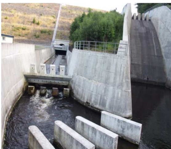
Obr. 5.2.2.6 Přepad a odtok z hráze
