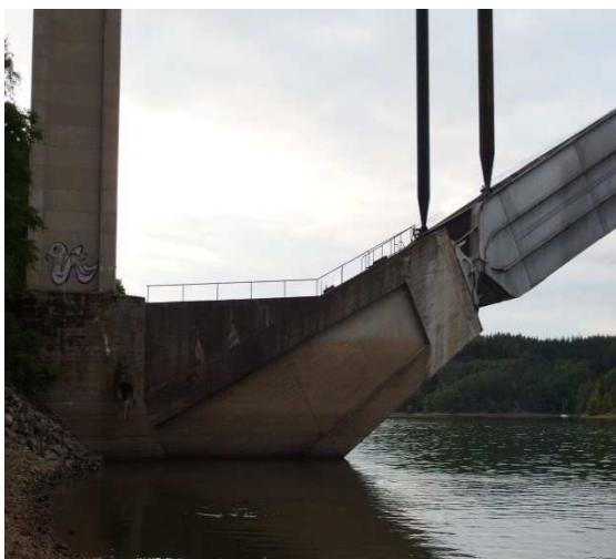
Obr.5.1.6.2 Betonový pilíř mostu
