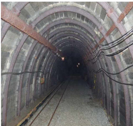
Obr. 2.3.2 Hlavní štola s ocelovými výztuhami Obr. 2.3.3 Překop vyztužený výdřevou
