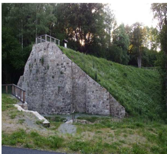
Obr. 3.1.24 Opěrná zeď mostu a násep
