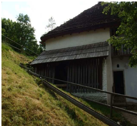
Obr.4.3.3 Přístřešek pro vodní kolo zvaný lednice
