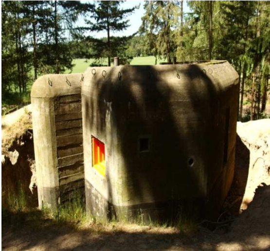
Obr. 6.2.14 Objekt A-140 (č.1052)
