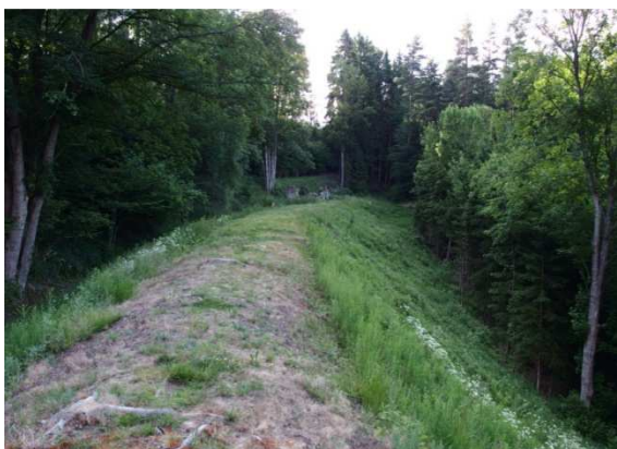
Obr. 3.1.25 Násep a vzadu zbytky strážního domku u Dolního Dvořiště
