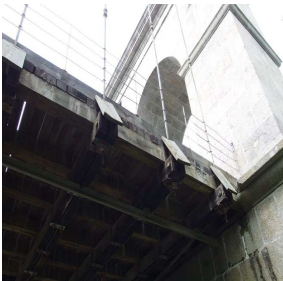
Obr. 5.1.3.4 Uchytení mostovky
