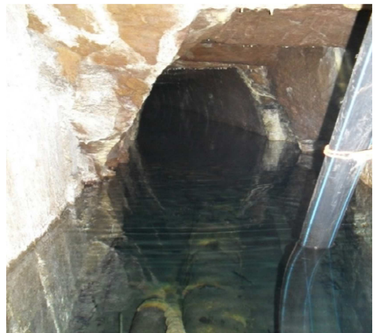
Obr. 2.1.8 Zavodněná část štoly, ze které se čerpá voda pro „Oslí kašnu“ z r. 2013
