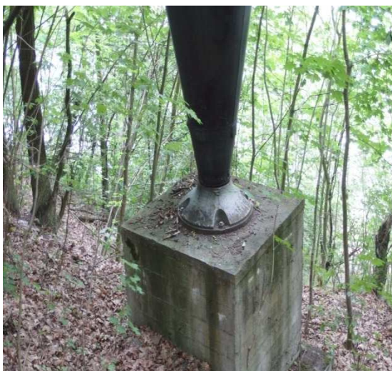
Obr.5.1.6.5 Ukotvení ocelové vzpěry mostovky
