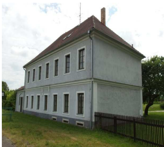
Obr. 3.1.11 Bujanov přeprážní stanice dnes
