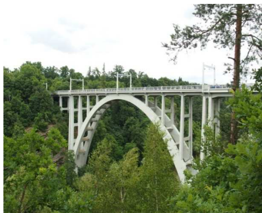
Obr.5.1.4.2 celkový pohled na most
