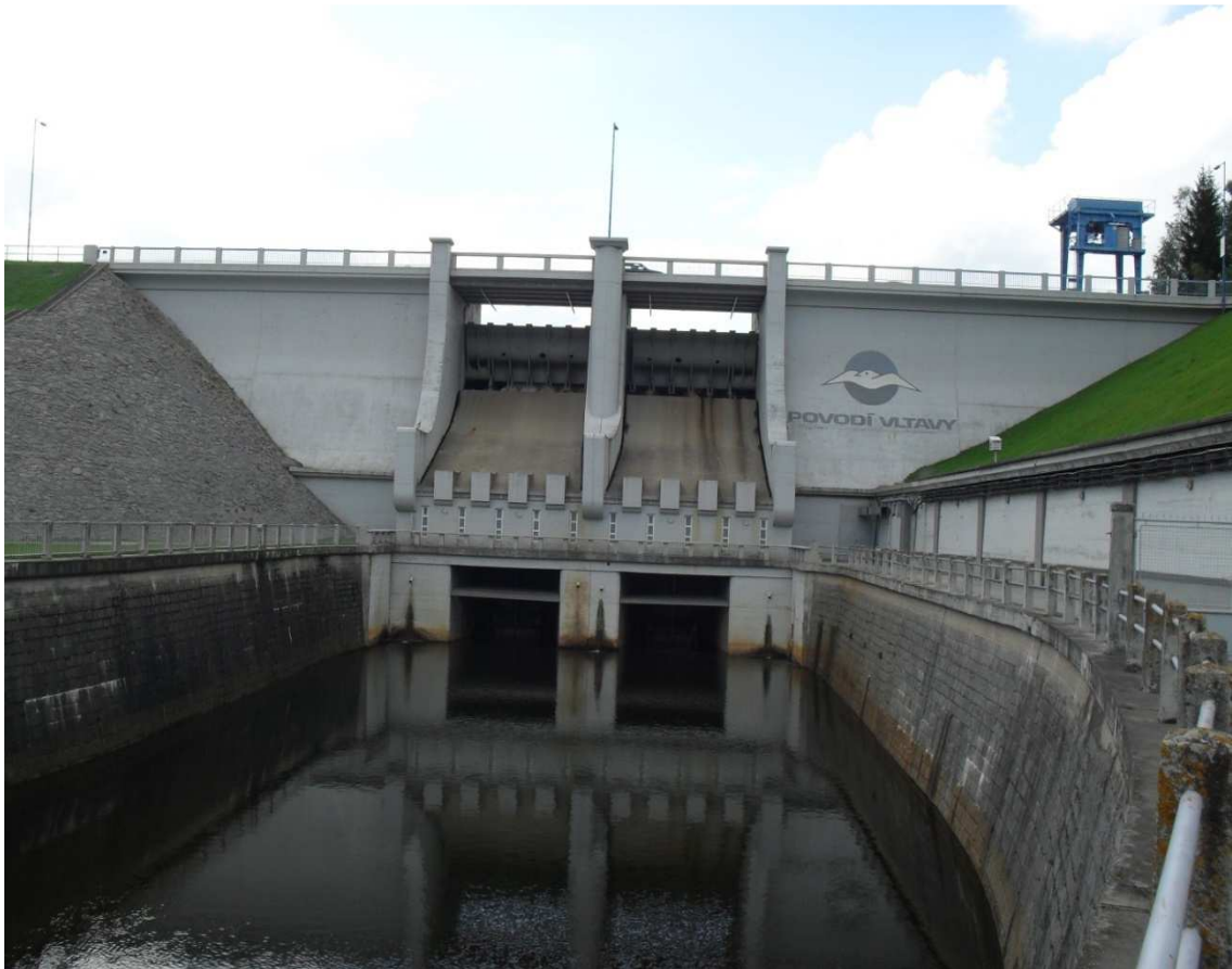
Obr. 5.2.3.1 Hráz vodního díla Lipno, betonová gravitační část s propustmi
