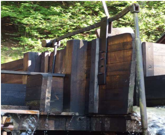
Obr. 4.2.4 Mechanismus pouštění vody
