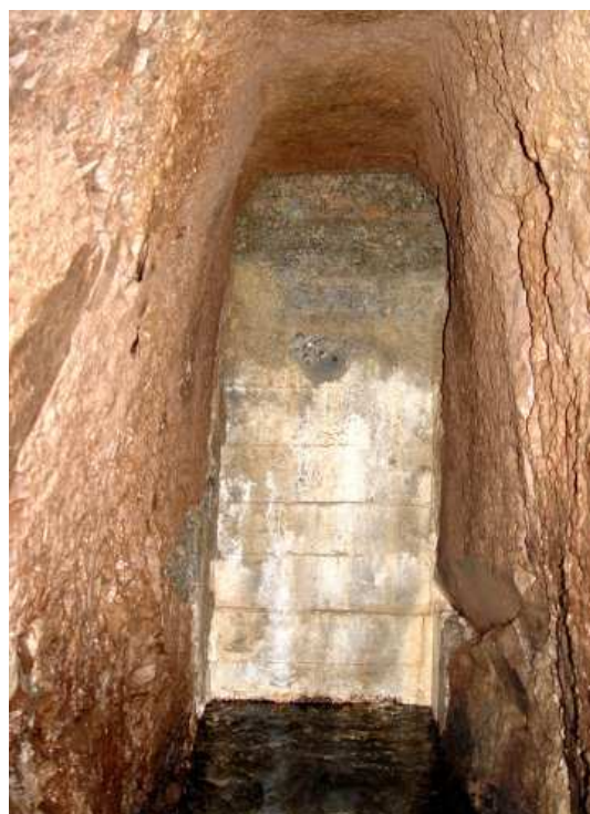
Obr. 2.1.10 Betonová uzávěra silná 3m, převzato a upraveno z [6]
