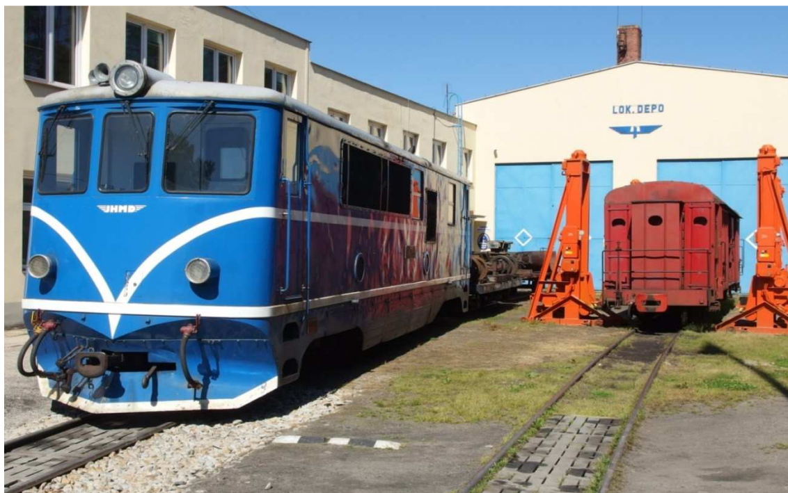
Obr. 3.2.1 Depo úzkorozchodné železnice v Jindřichově Hradci
