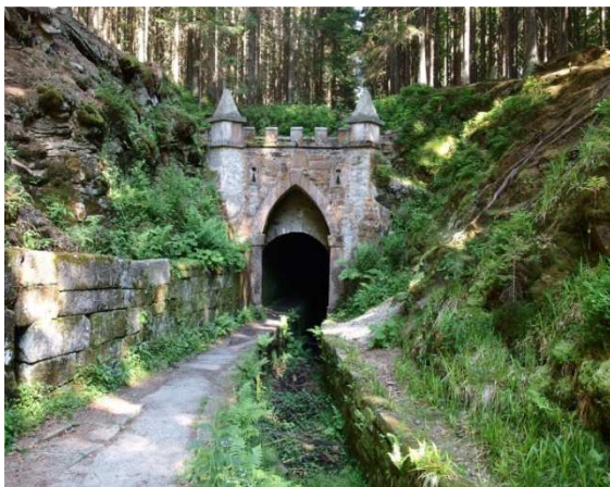
Obr. 3.3.1 Horní portál tunelu
