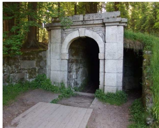
Obr. 3.3.2 Dolní portál tunelu
