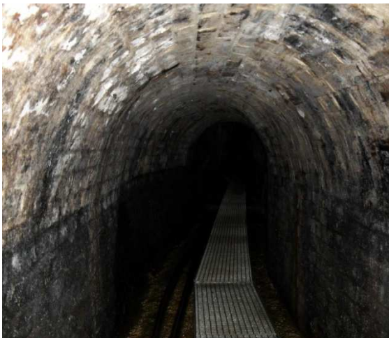
Obr. 2.1.7 Upravená část štoly z r. 1936
