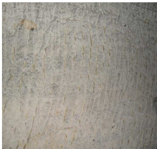
Obr. 2.2.8 Rýhy po kopání špičáky Hosín I.
