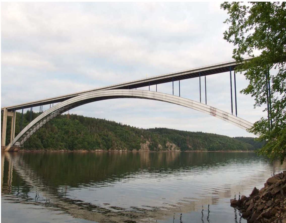
Obr.5.1.6.1 Celkový pohled na Žďákovský most
