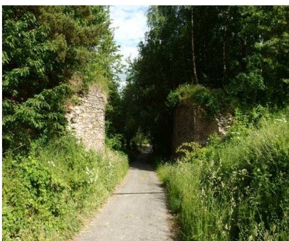
Obr. 3.1.15 Opěrné pilíře mostu u Trojan
