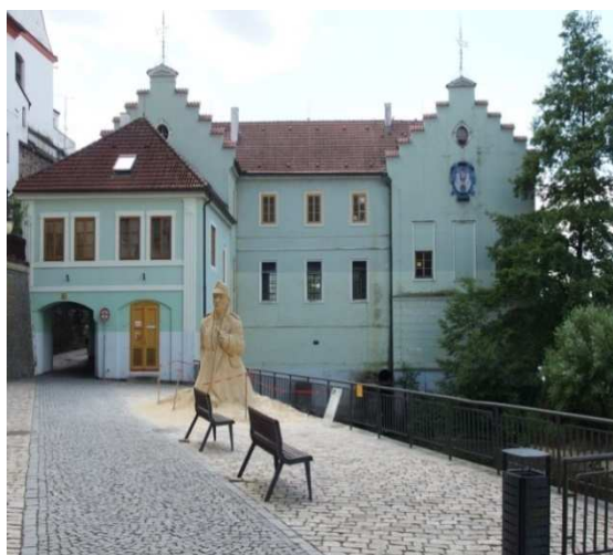
Obr.4.4.1 Městská elektrárna Písek
