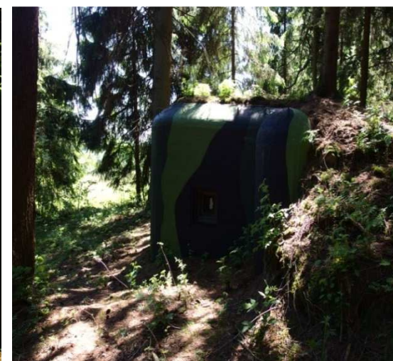
Obr. 6.2.13 Objekt A-160 v držení A.Č.R.
