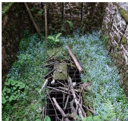
Obr. 3.3.4 Kontrolní šachta tunelu
