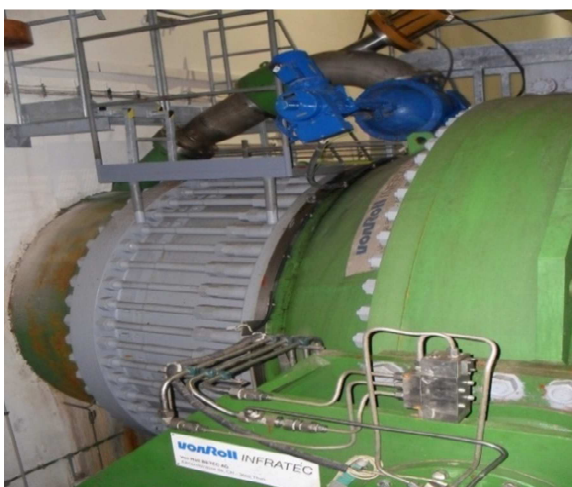
Obr. 5.2.3.6 Uzávěr přívodního potrubí
