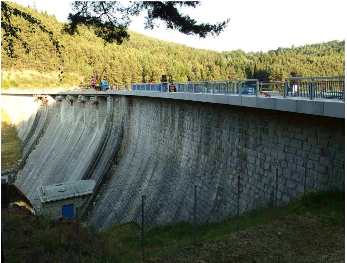
Obr. 5.2.1.1 Zděná hráz Husinecké přehrady
