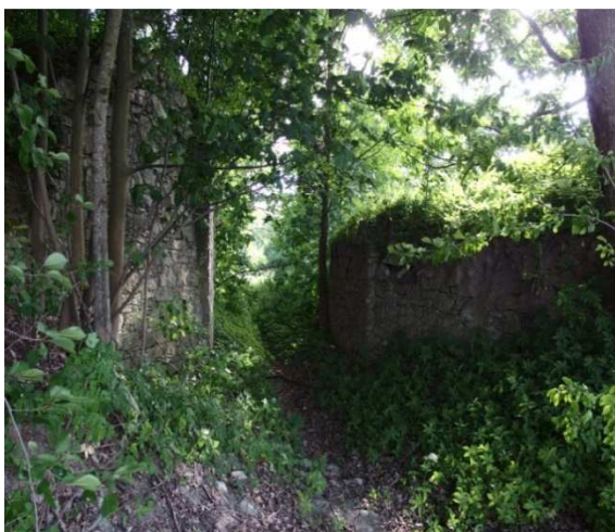
Obr. 3.1.19 Opěrné pilíře mostu Rybník
