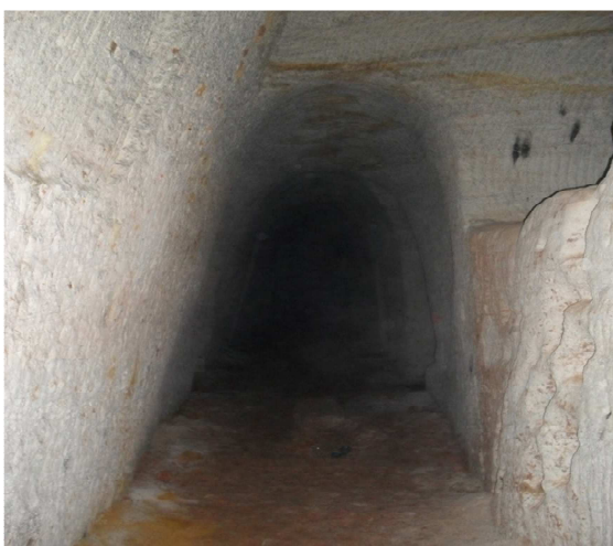
Obr. 2.2.9 Chodba s nedokončenou boční chodbou Hosín I.
