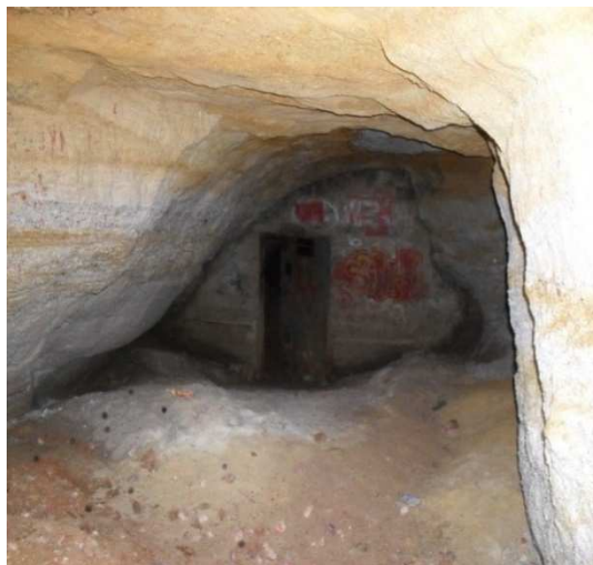
Obr. 2.2.2 Uzávěr betonovou stěnou
