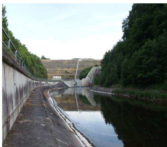
Obr. 5.2.2.7 Sanační odtok z hráze
