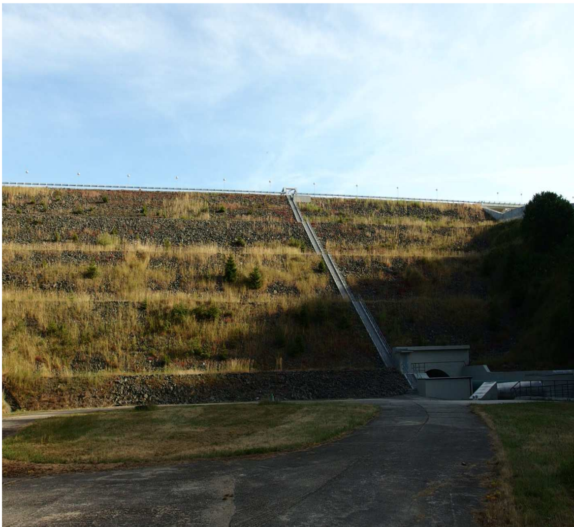
Obr. 5.2.2.1 Sypaná hráz římovské přehrady
