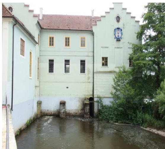
Obr.4.4.2 Městská elektrárna Písek detail
