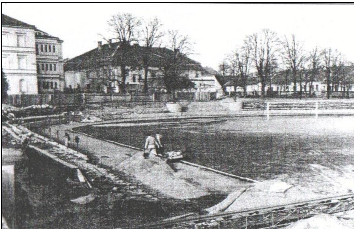
Příloha č. 10. Výstavba fotbalového stadionu v Telči v padesátých letech. Fotografie převzata z Fabeš, R. (1999). Fotbalový oddíl Sk Telč.
