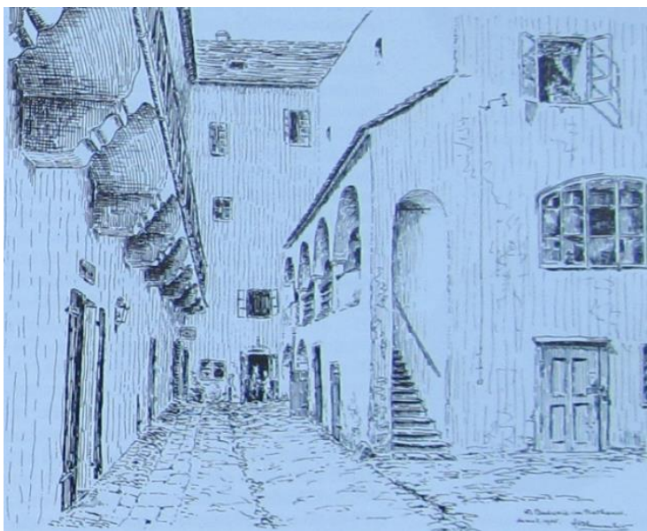
Obrázek 4: Radnice: klasicistní úprava radničního nádvoří s budovou městského vězení na kresbě F. Blumentritta; JČM.
