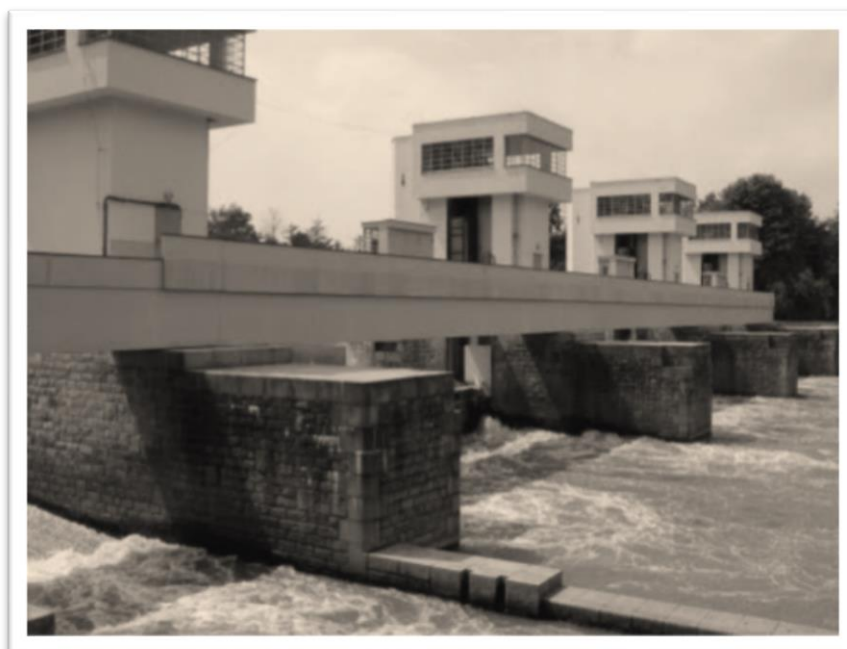
Obrázek 21. Pohyblivý jez v Hluboké nad Vltavou s výškou 2,15 m a dlouhou retardérkou, který byl postaven ve 30. letech. Jeho průjezd, nebo eventuální dlouhé přenašení záležely na typu lodi a také vodním stavu.
