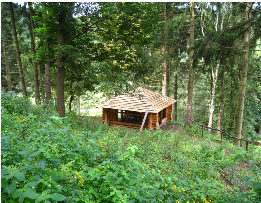
Srub v roce 2010 – pohled shora (foto vlastní)
