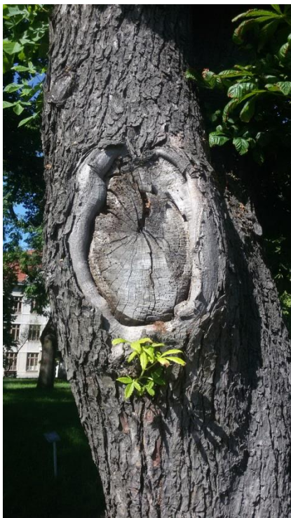
Ukázka dřívějšího špatně vedeného řezu na dřevině č. 1 jírovec maďal (foto vlastní)
