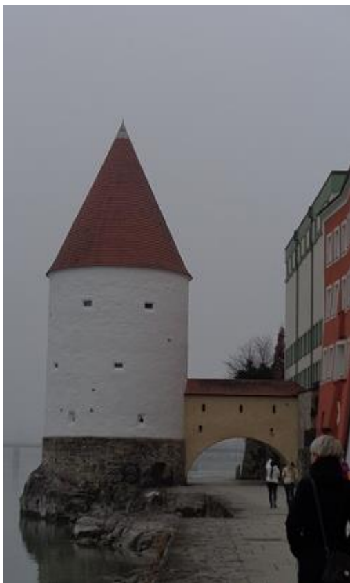
Obrázek 38: Stavba u soutoku řek v Pasově
