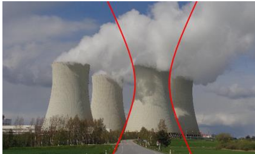
Obrázek 26: Chladicí věže JE Temelín
