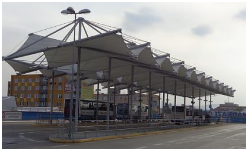
Obrázek 17: Zastřešení autobusového nádraží v Českých Budějovicích 1
