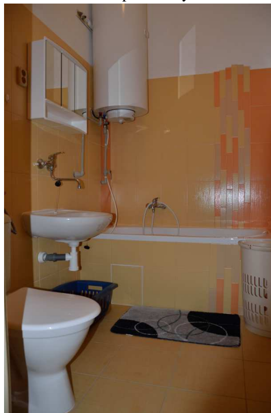
Obrázek č. 2 – koupelna v bytě č. 6 v DMD
