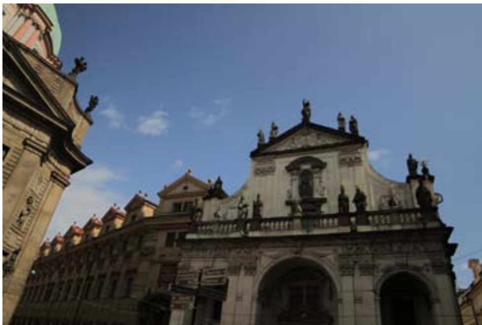
Obrázek 1: Průčelí kostela sv. Salvátora.
