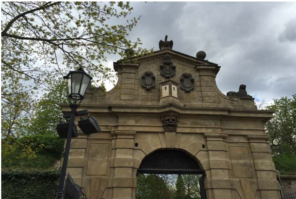
Obrázek 6: Leopoldova brána – pilastry přepásané rustikovými bosami.
