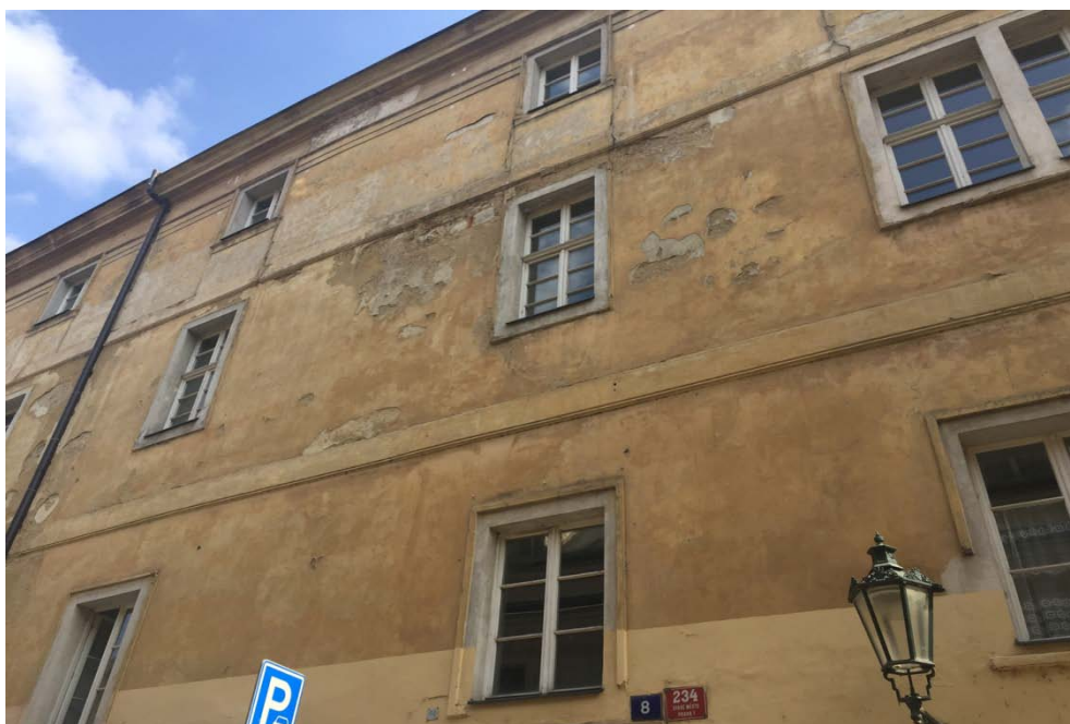
Obrázek 14: Strohá budova konventu dominikánů u kostela sv. Jiljí.
