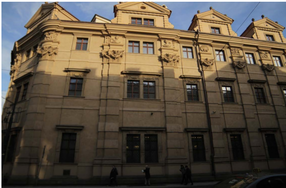
Obrázek 31: Nejstarší křídlo Klementina, které se obrací do Křižovnické ulice. Je zde použito vysokého pilastrového řádu, který spojuje všechna podlaží.
