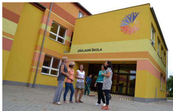
Foto 12: Základní škola Dříteň po rekonstrukci. [11]
