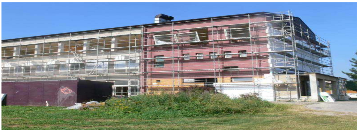
Foto 22: Probíhající práce na zateplování budovy ZŠ Lišov. [19]
