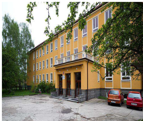
Foto 16: Budova školy po zateplení a výměně oken. [15]
