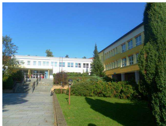
Foto 19: Vstupní pavilon ZŠ Hluboká nad Vltavou po rekonstrukci a zateplení (2012 – 2013). [18]
