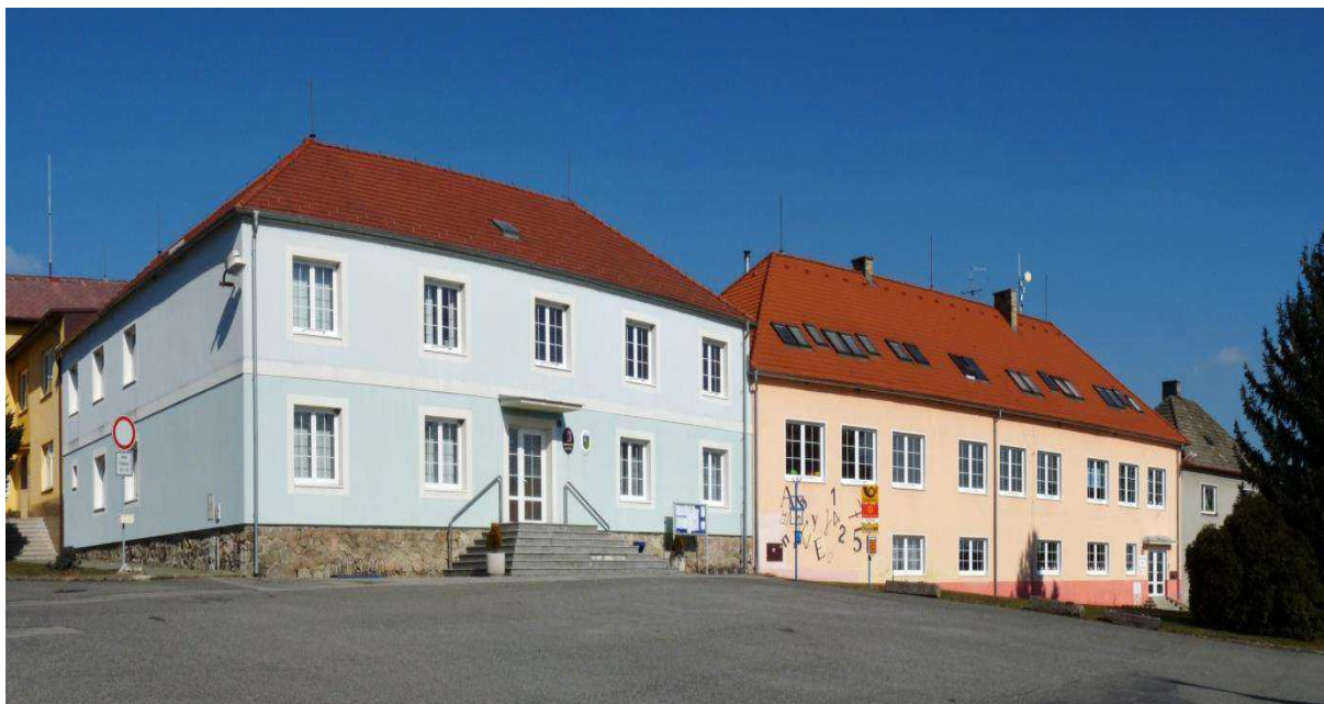
Foto 4: Budova základní školy v Olešniku (vpravo), vlevo se nachází obecní úřad. [4]
