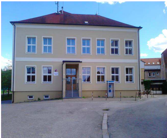
Foto 48: Budova ZŠ Rudolfov po rekonstrukci. [Vlastní foto]
