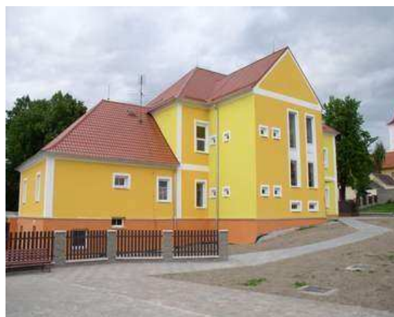
Foto 5: Opravená budova malotřídní ZŠ Zahájí. [5]
