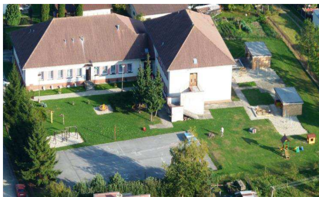
Foto 6: Areál a budovy Základní školy Štěpánovice. [6]
