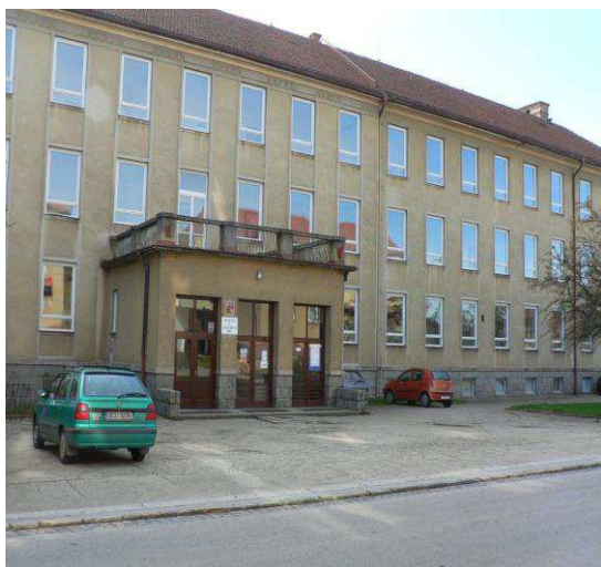
Foto 15: Budova ZŠ Zliv před rekonstrukcí. [14]
