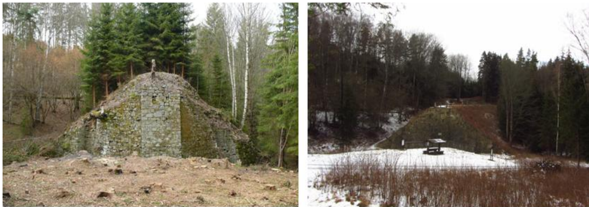
Obrázek č. 5 – Porovnání stavu dalšího mostu. Vpravo rok 2011, vlevo stav v roce 2016
