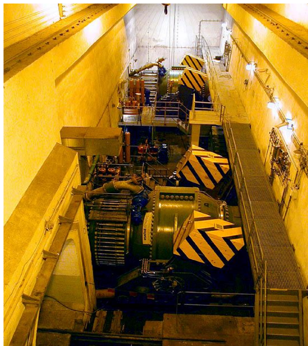
Obrázek č. 18 – Interiér elektrárny( kulové ventily), zdroj: www.ckrumlov.cz
