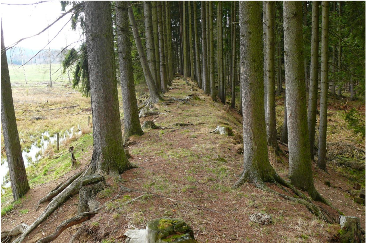
Obrázek č. 2 – Dobře patrné těleso dráhy za stanicí Rybník
