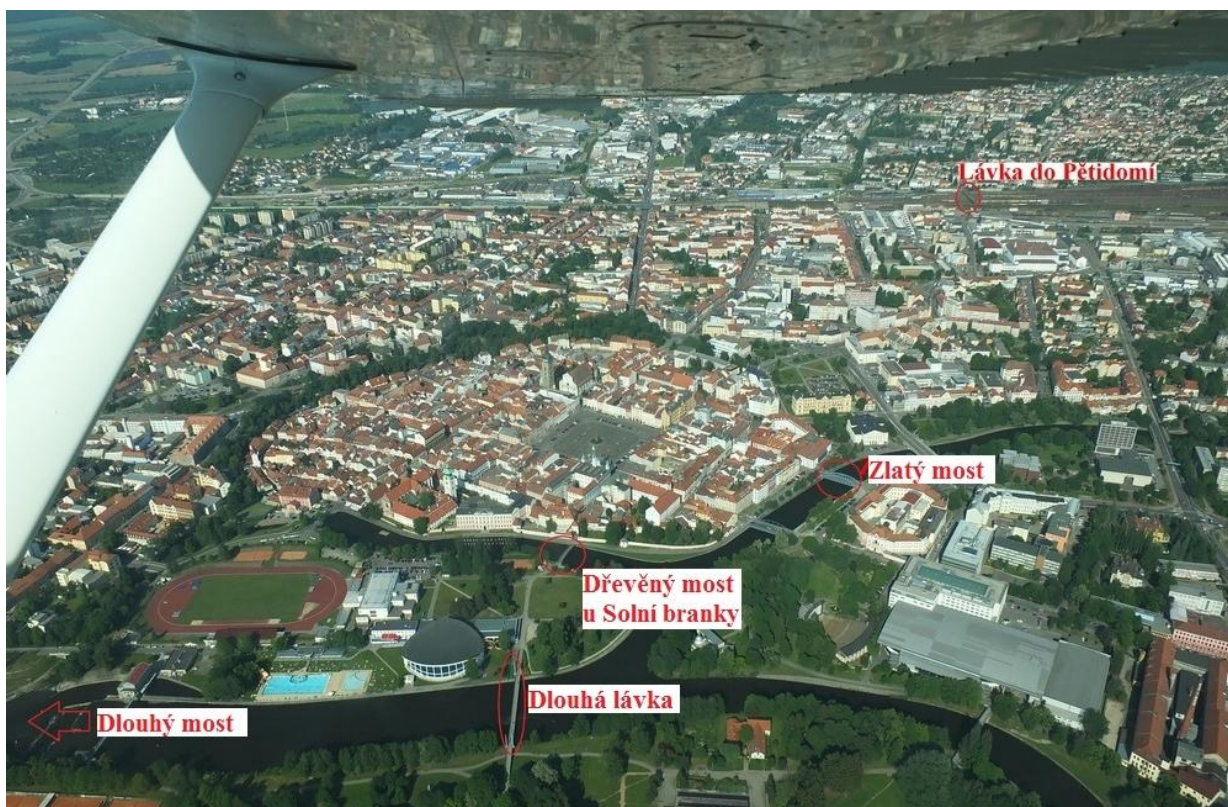
Obrázek č. 11 – letecký pohled na mosty v Českých Budějovicích
