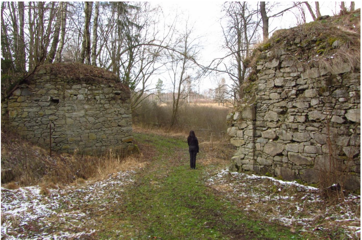
Obrázek č. 3 – Pilíře mostů na začátku naučné stezky v porovnání s dospělým člověkem (180cm)
