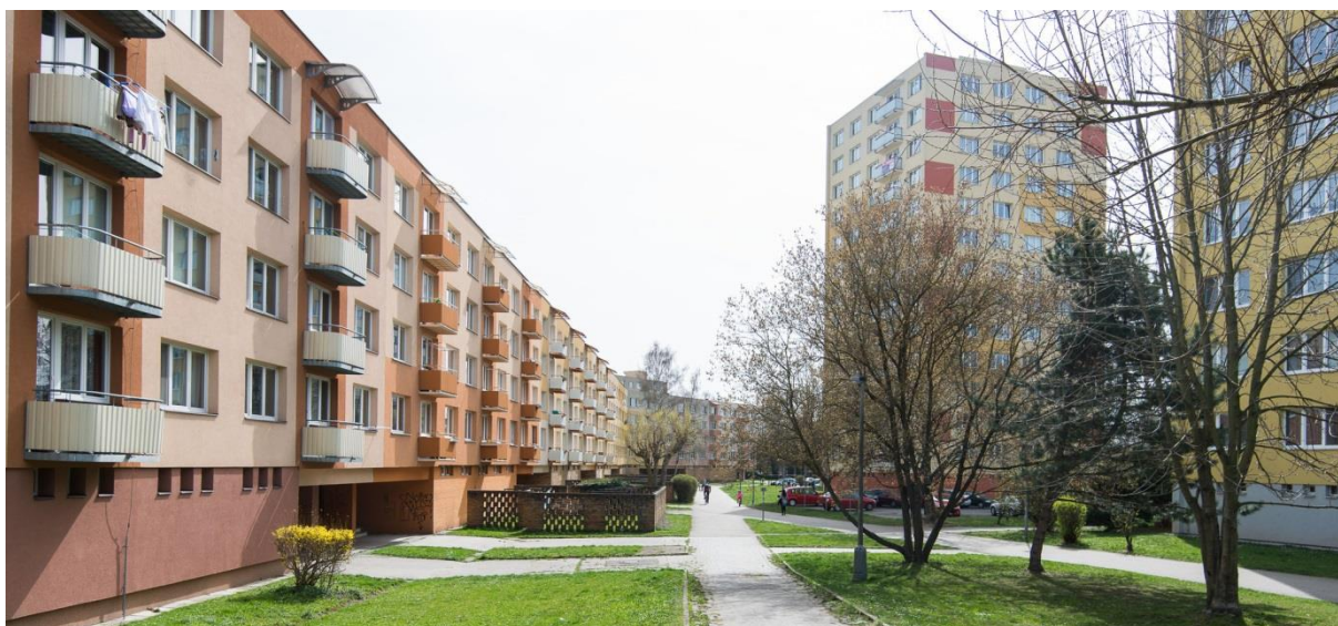
Foto 2. Řešená plocha č. 1 - Pražské sídliště, ukázka vnitřních prostor sídliště ( http://www.panelaci.cz/sites/default/files/jc_ceske_prazskasidl_starom_jr0_005_no8_staromestska25_celni_fasada.jpg_resized.jpg )
