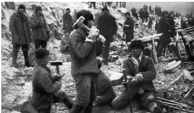
Obrázek č. 12: Stavba Bělomořsko – baltského kanálu
