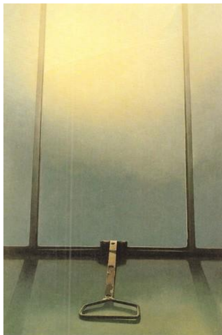
Obr. 36) Ateliérové okno I
