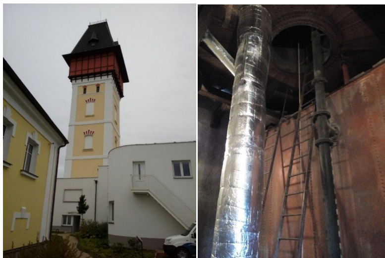
Obrázek č. 2 a obrázek č. 3 – Vodárenská věž
