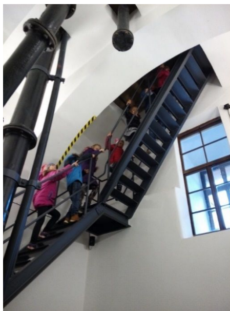
Obrázek č. 4 – schodiště Vodárenské věže
