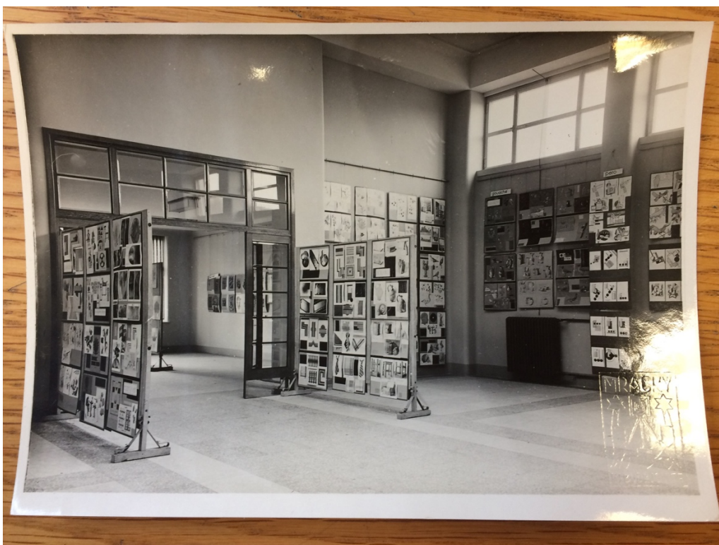
Obr. č. 19 Fotodokumentace výstavy studentských prací pod vedením E. Pittera 1933
