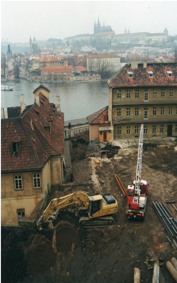
Obr. 15: Alšovo náměstí, Praha. Pohled na stavební jámu.
