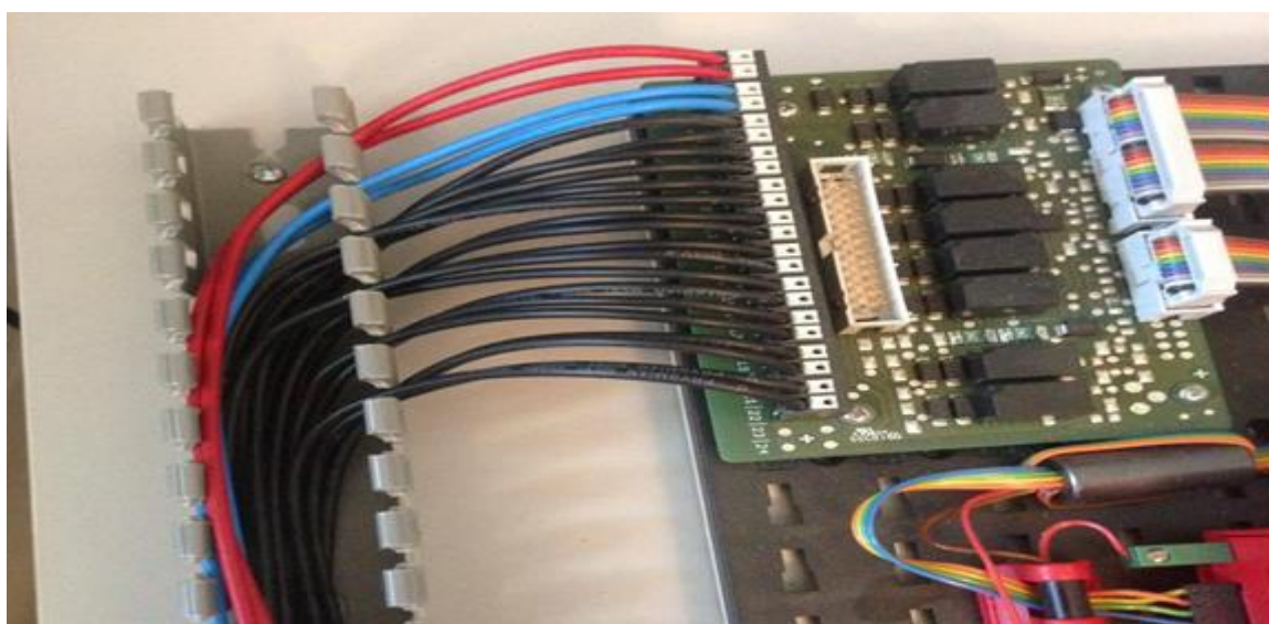
Příloha 2: Uložení kabelů do rozvaděčového kanálu.
