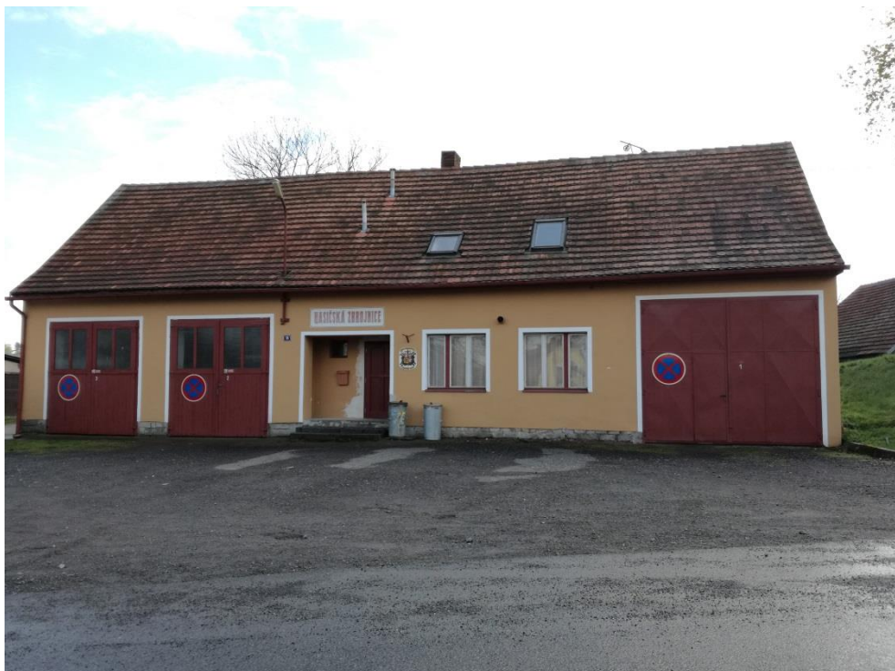
Obrázek 35: Hasičská zbrojnice Dublovice
