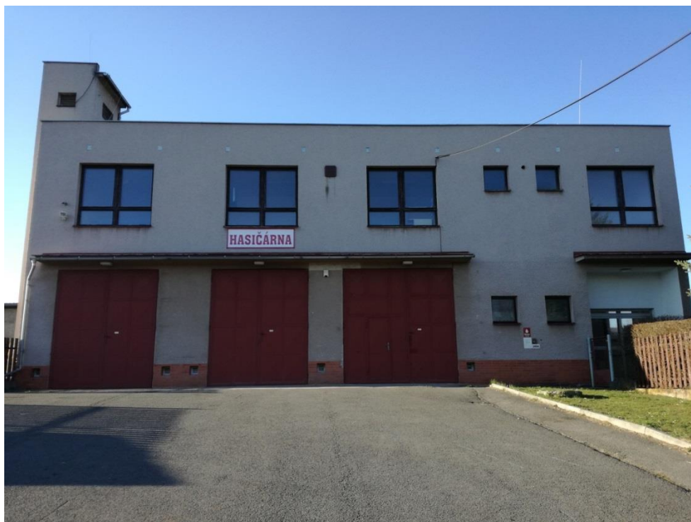
Obrázek 32: Hasičská zbrojnice Petrovice
