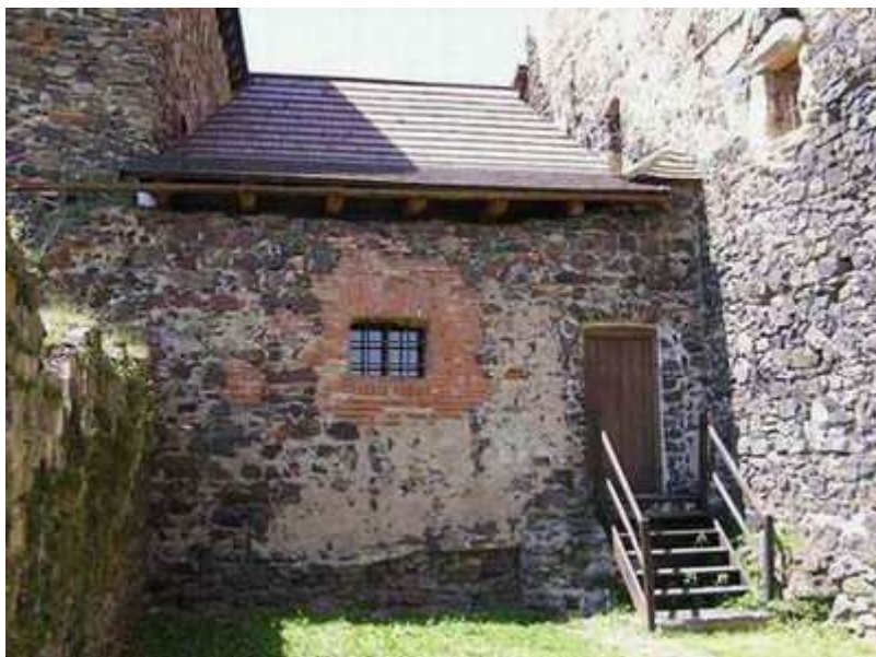
Obrázek 15- Vstup do kuchyně
