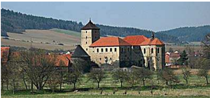
Obrázek 22- Švihov (pohled od silnice E53)
