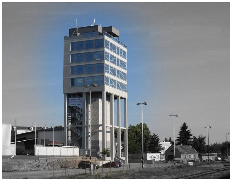
Obr. č. 32: Silo Tower v Olomouci - současný stav [22]
