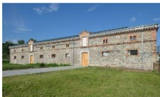
Obr. č. 38: Konírna - současný stav [22]
