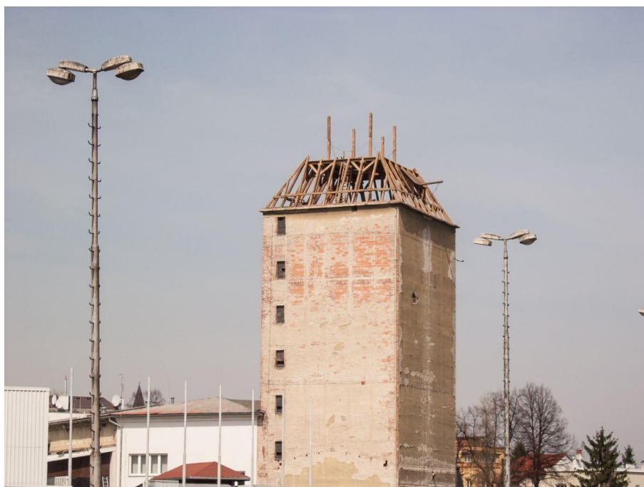
Obr. č. 31: Silo Tower v Olomouci - původní stav [22]
