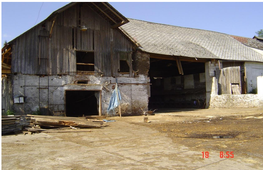
Obrázek 6 - Stáj před rekonstrukcí v roce 2001
