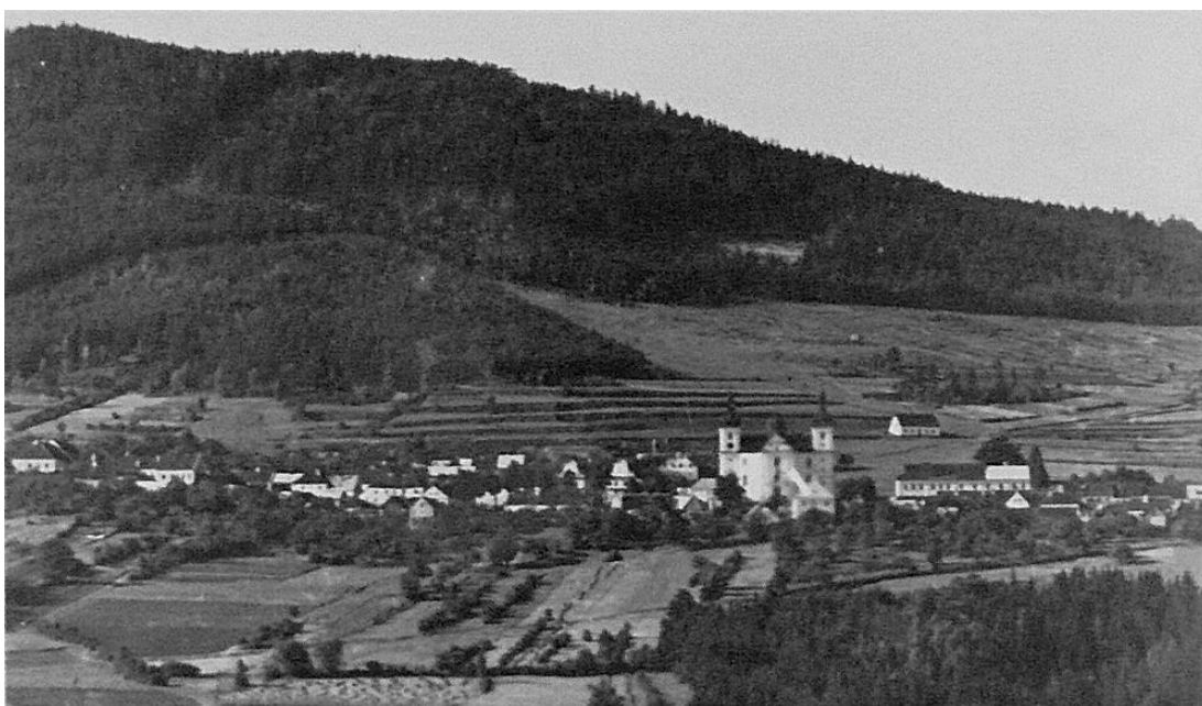
Obr. č. 17 Pohled na obec Dobrá Voda od Horní Stropnice (dostupné z www.pietasamfi.eu )
