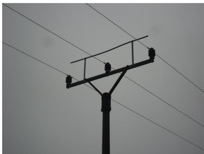
Obr. č. 2 „Lavička“. Úplně první typ zabezpečení nebezpečných konzolí. Foto-autor.
