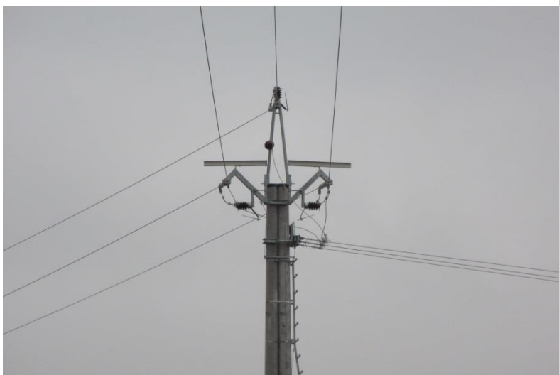
Obr. č 8 Konzola pařát III - R – JB. Typ, který umožňuje bezpečné dosednutí. Foto-autor.
