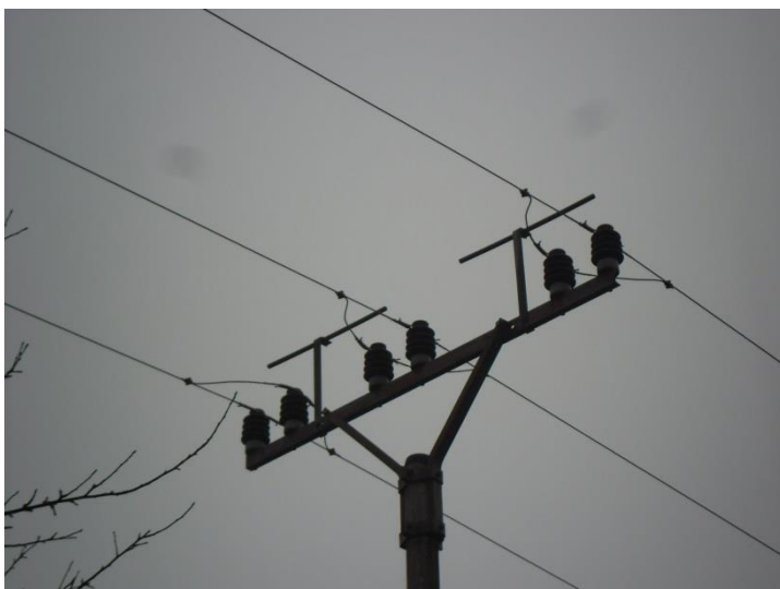
Obr. č. 3 „Lavička“ v půleném provedení. Její funkce zůstává stejná. Foto-autor.
