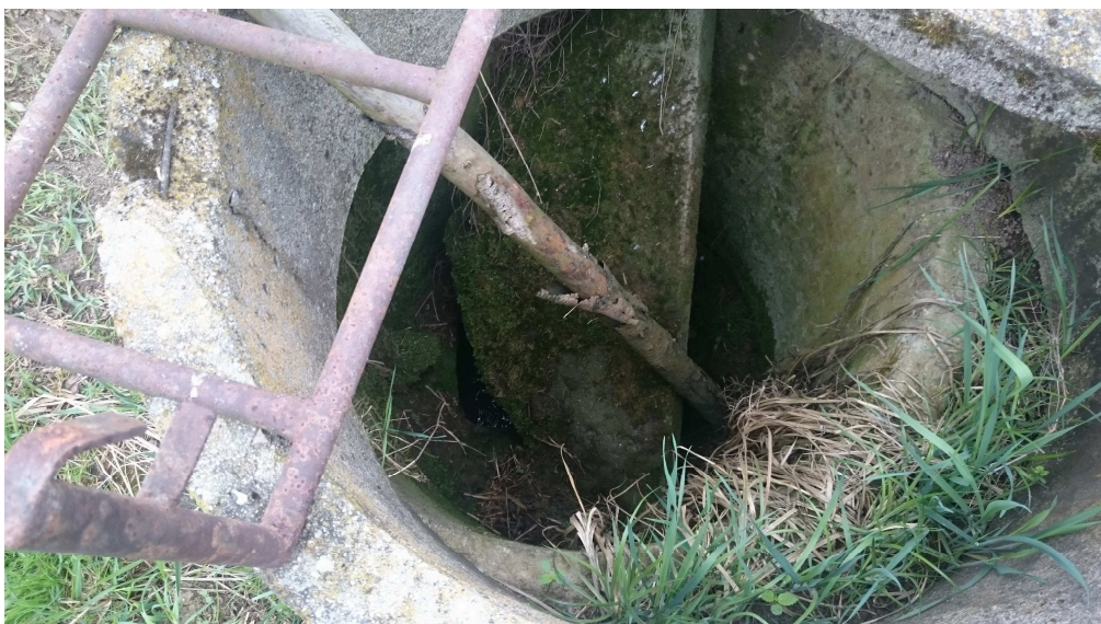
Foto č. 13: Stav první revizní šachtice na hlavním odvodňovacím zařízení poblíž lokality 2, Ke strouhám. Zdroj: Eva Mikulová
