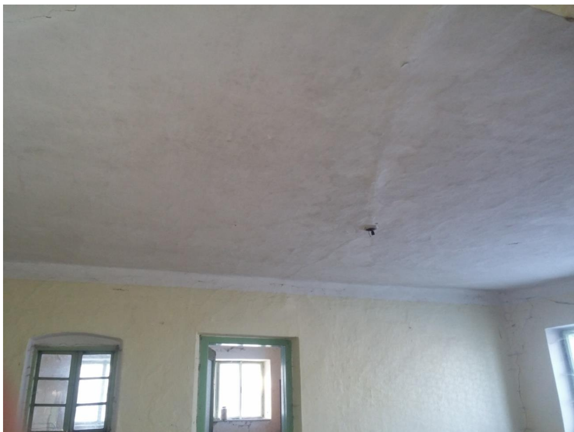
Obr. č. 19 – Pohled na omítnutou stropní konstrukci, která svědčí o zachovalém stavu.
