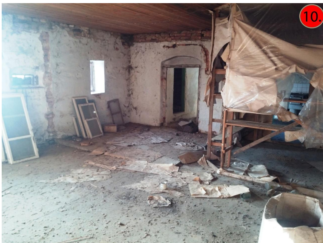
Obr. č. 16 – Jihozápadní pohled do obytné části, vpravo kuchyně (Zdroj: vlastní šetření)
