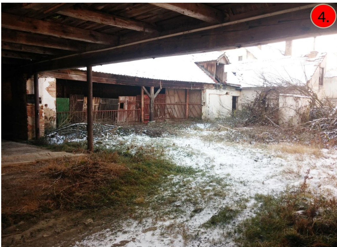
Obr. č. 10 – Jihozápadní pohled na dvůr, hospodářská část (Zdroj: vlastní šetření)
