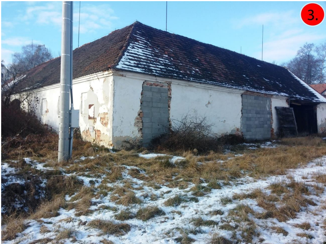
Obr. č. 9 – Severozápadní pohled na původní stodolu (Zdroj: vlastní šetření)
