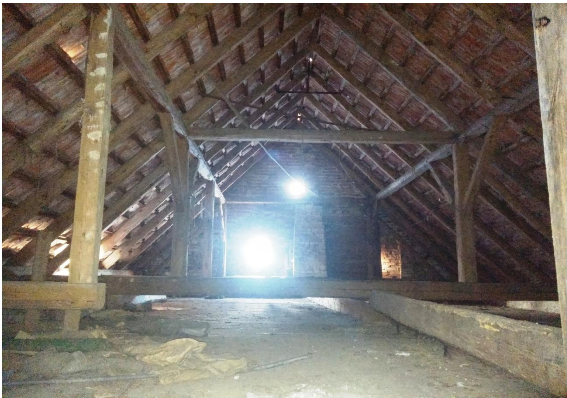
Obr. č. 18 – Západní pohled půdního prostoru, kde vznikne obytný prostor pro hosty (Zdroj: vlastní šetření)
