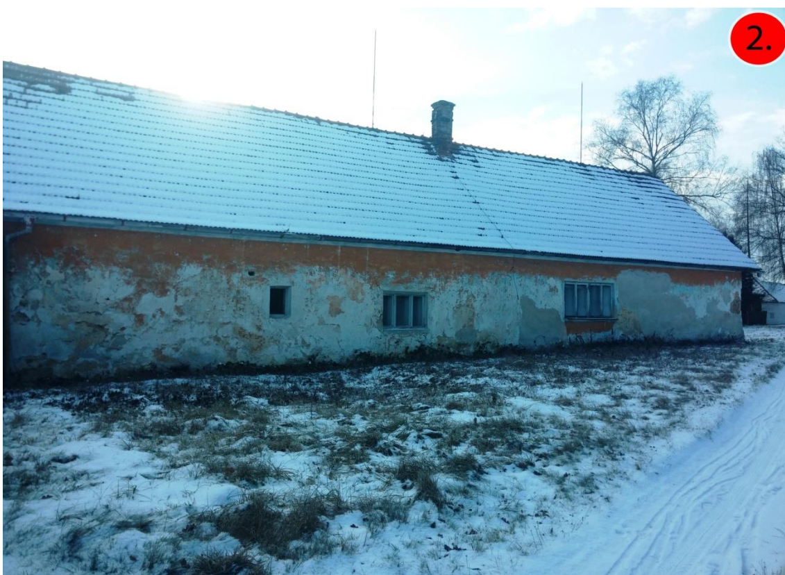
Obr. č. 8 – Jihozápadní pohled na obytnou část (Zdroj: vlastní šetření)
