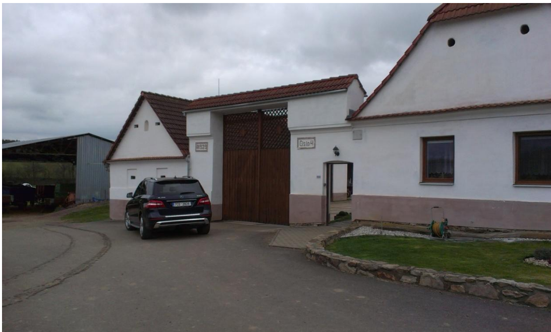
Obrázek 21 – Vjezdová vrata do dvora
