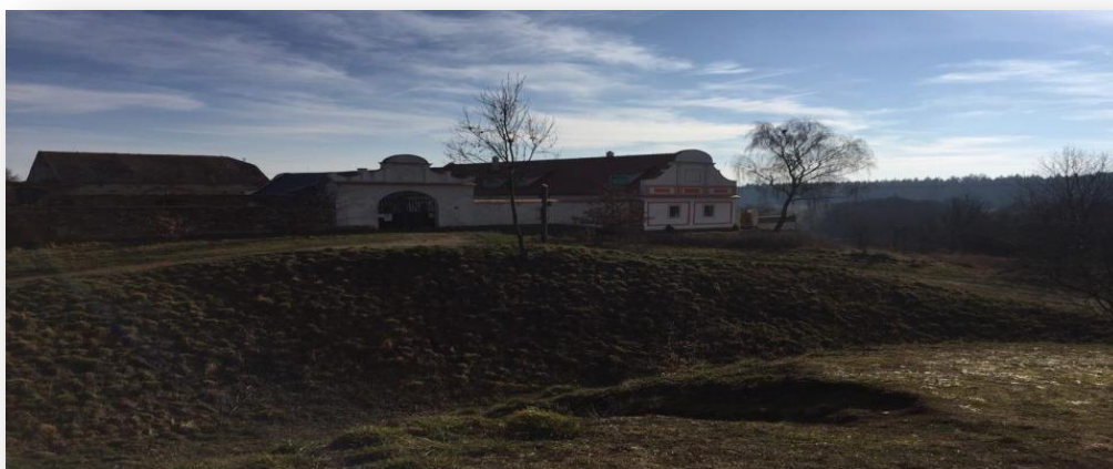
Obr. 11: Z části zrekonstruovaná část Barokního dvora
