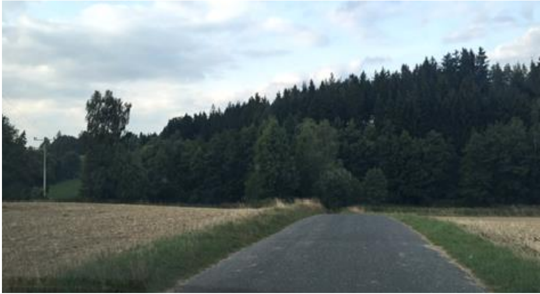
Obrázek 19: Místní komunikace - C7
