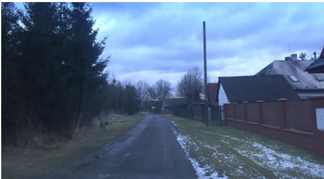
Obrázek 15: Místní komunikace C3
