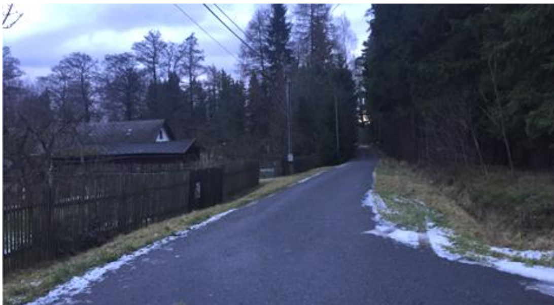
Obrázek 16: Místní komunikace C4
