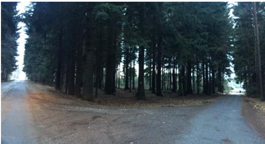
Obrázek 14: Místní komunikace C2
