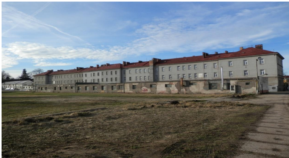
Obrázek 4: Bývalý ubytovací objekt kasáren (O2)
