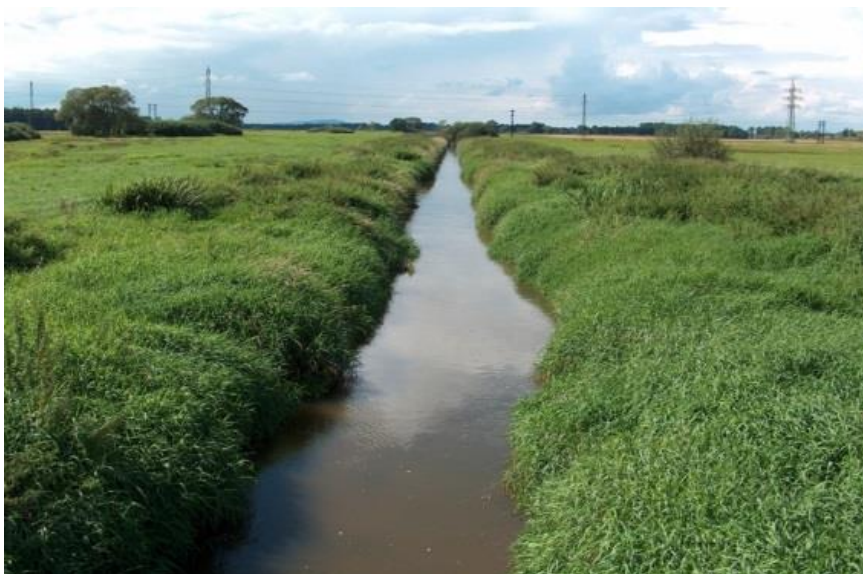
Fotografie č. 2: Pohled na protékající potok
