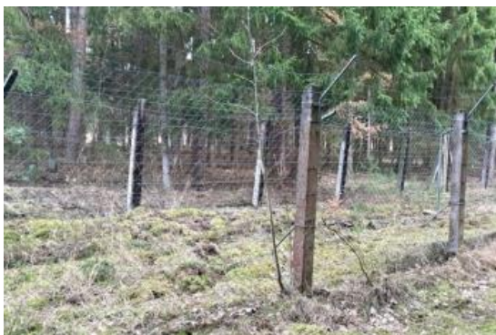
Trojité ploty okolo bývalého muničního skladu
