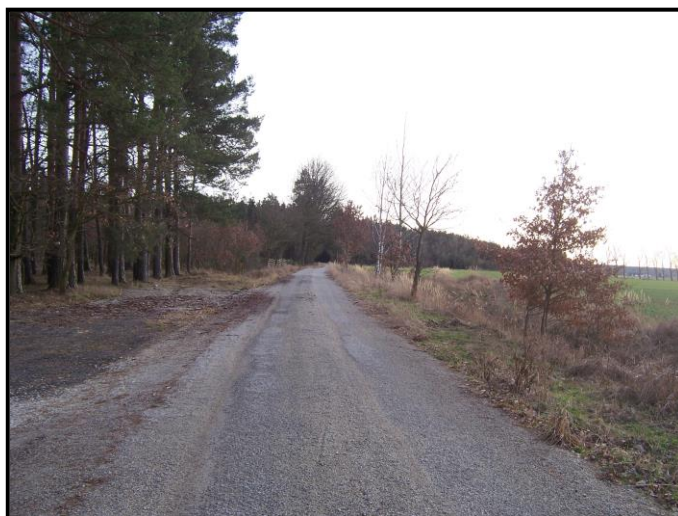
Pv10 – rekonstrukce krytu, dosypání a zarovnání
