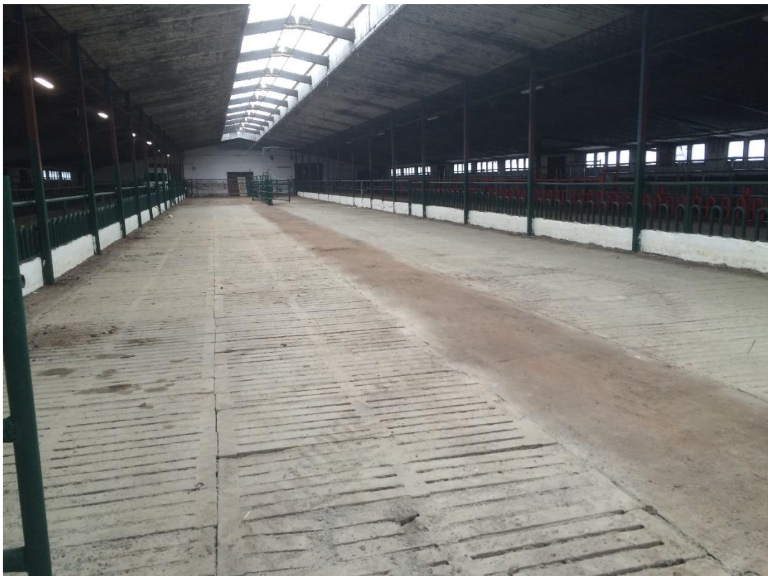
Obrázek 12: Stavební úpravy na stáji Trojany – zvýšení pohody ustájených zvířat zasypáním roštů a zvětšení prostoru pro ustájení
