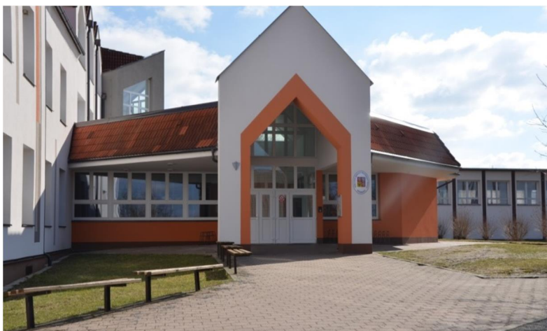
Obrázek . 7 : Základní –kola (vchod)
