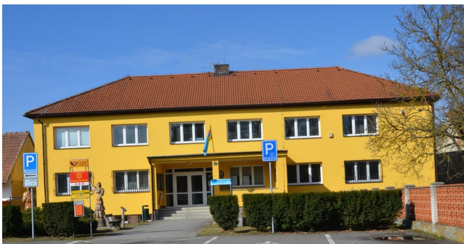
Obrázek . 4: Budova obecního úřadu, pošty a dalších podnik
