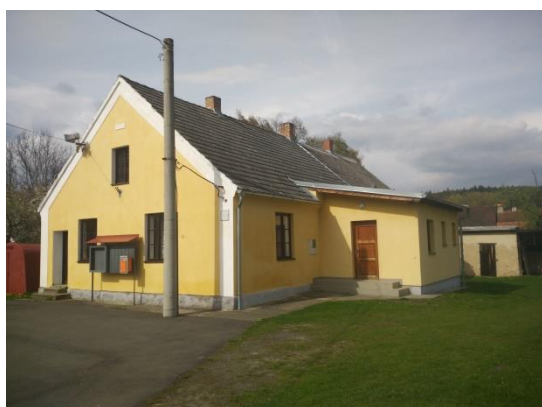
Obrázek 17 Hasičská zbrojnice v Třebýcince
