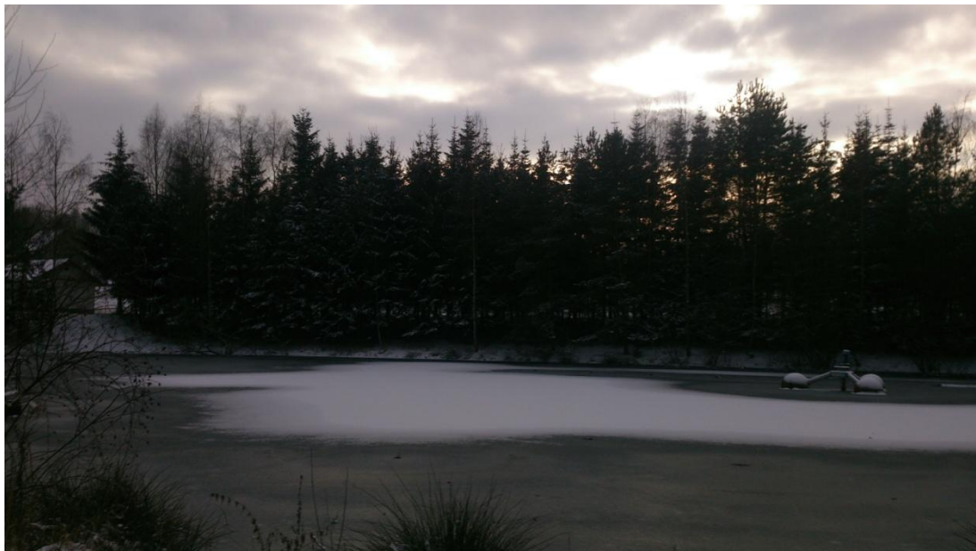
Obrázek č.19: Vodní nádrž s čistírnou odpadních vod
