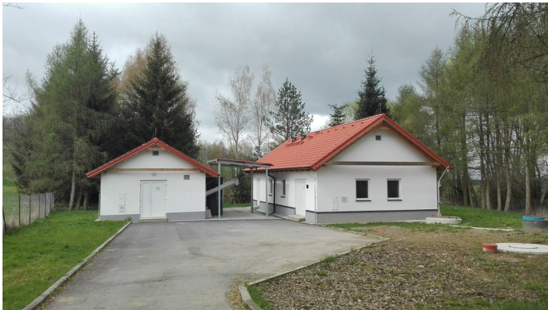
Obrázek č.20: ČOV v obci
