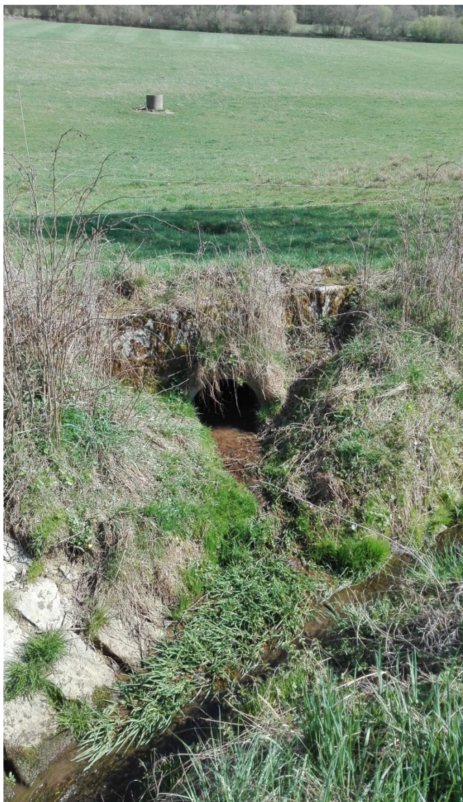
Obrázek č.6: Meliorační systém svedený do Mirkovického potoka
